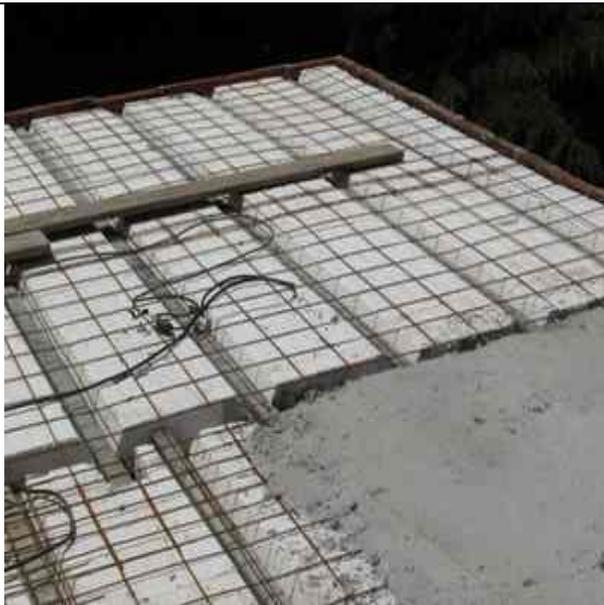
Una vez dispuesta la configuración de viguetas y bovedillas se procede a colocar malla electrosoldada y realizar un colado de concreto.
