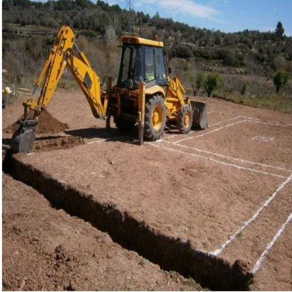
Tal como se mencionó las cepas de cimentación se realizarán utilizando una retroexcavadora con ayuda de un martillo neumático.
