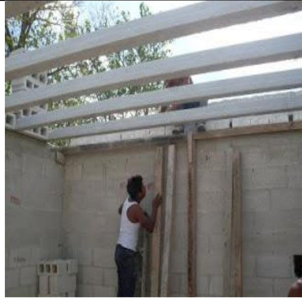
Una vez realizado el colado de cerramientos se procede a asentar viguetas y bovedillas para conformar el techado de los cuartos que conformarán las instalaciones de la del edificio que albergará a los seis departamentos.
