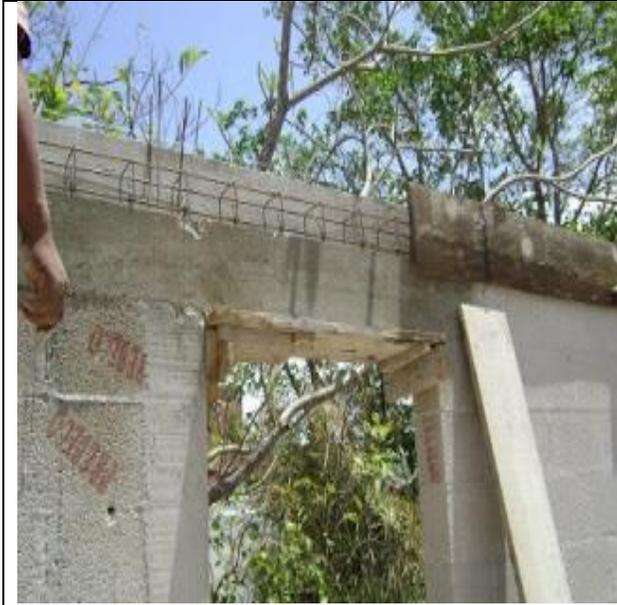
Posteriormente, se procede a colocar los bloques vibroprensados sobre las cadenas. Estos se unen con mortero (cemento, cal y agua) hasta llegar al nivel del techo. Sobre las paredes de bloques posteriormente se procede al colado de cerramientos (cadenas).
