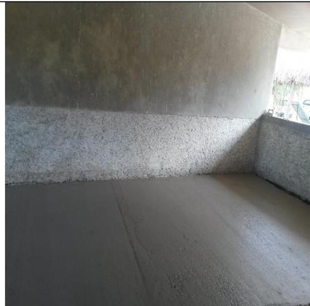
Colados los pisos de ambos niveles se procederá a revocar los techos con mortero y posteriormente las paredes. Se darán los acabados correspondientes al revoco según planos del proyecto.
