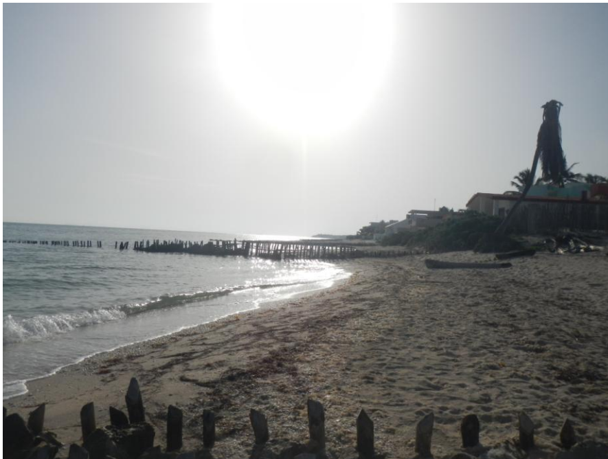
Fig. 4.4. Colocación de espigones en la zona de playa.
