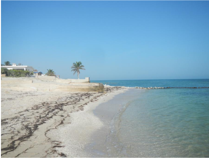
Fig. 4.3. Casas construidas sobre la primera duna, ocasionando serios problemas de erosión.
