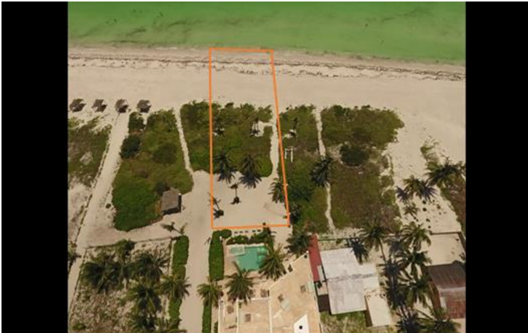
Figura 11: Vista aérea del sitio del proyecto.
