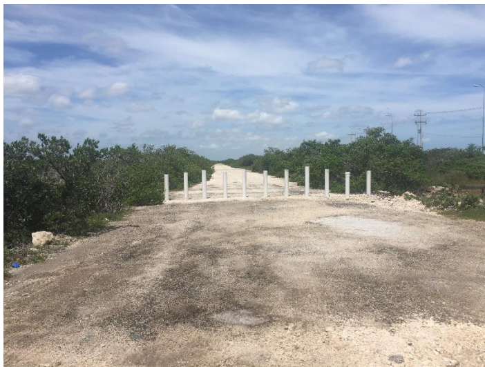
Fotografía 4. 1 Vista del acceso de la carretera antigua en el algo oriente.
