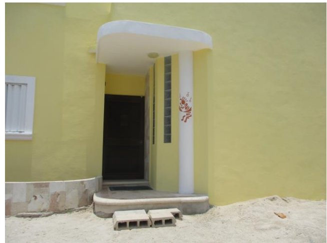
Fotografía 2 Urbanización de la zona: Viviendas.
