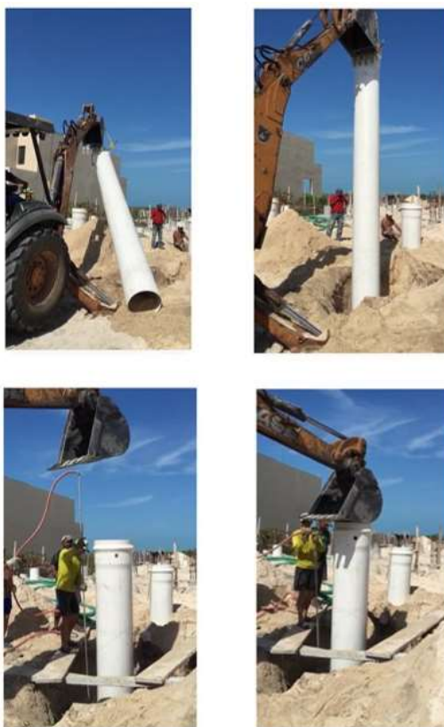
Figura 2.3. Ejemplificación del hincado de pilotes.
