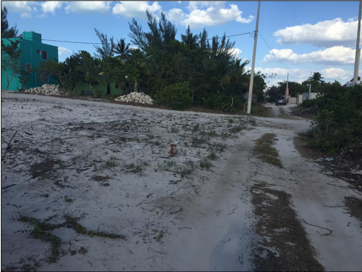
Fotografía No. 2.1. Vista de la calle principal donde se ubicará el proyecto.
