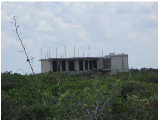
Fotografía 8 Viviendas en construcción.
