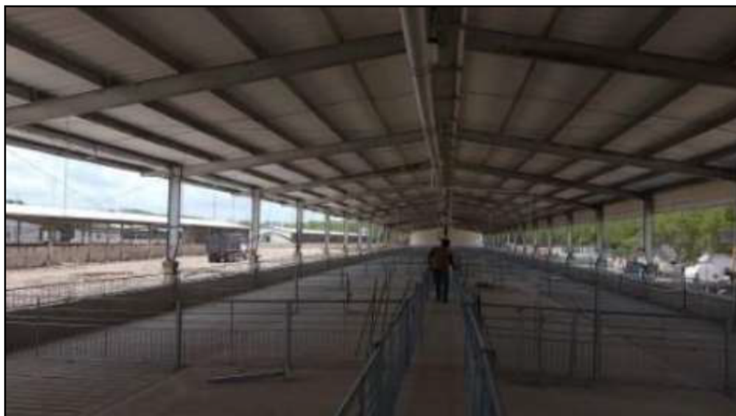
Figura II.7. Imagen ilustrativa del equipamiento en el interior de las naves.
