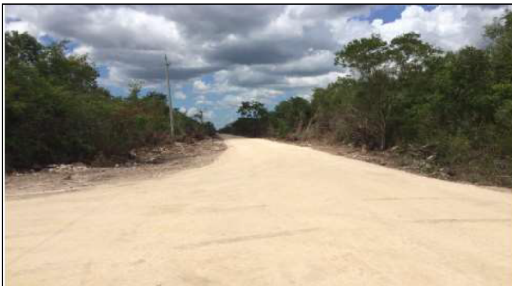
Figura II.8. Figura ilustrativa de la compactación y nivelación del camino de acceso.
