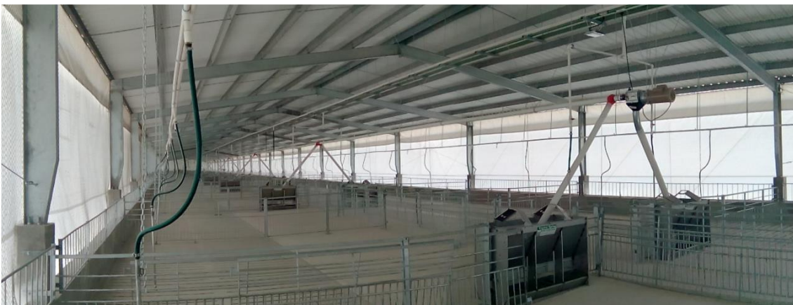
Figura 15. Vista ejemplo de estructura metálica.
