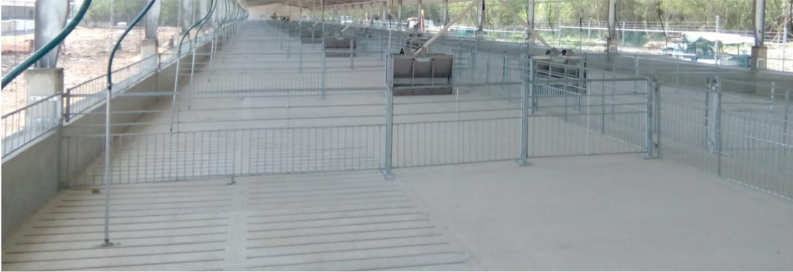
Figura 17. Vista ejemplo de corrales.
