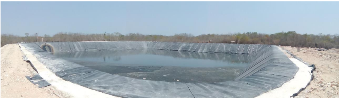
Figura 24. Vista ejemplo de biodigestor
