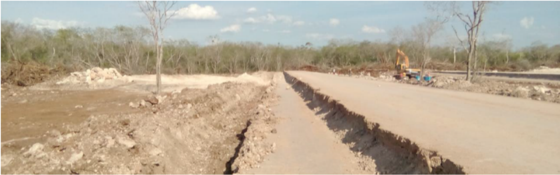
Figura 8. Vista ejemplo de terracerías y terraplenes.
