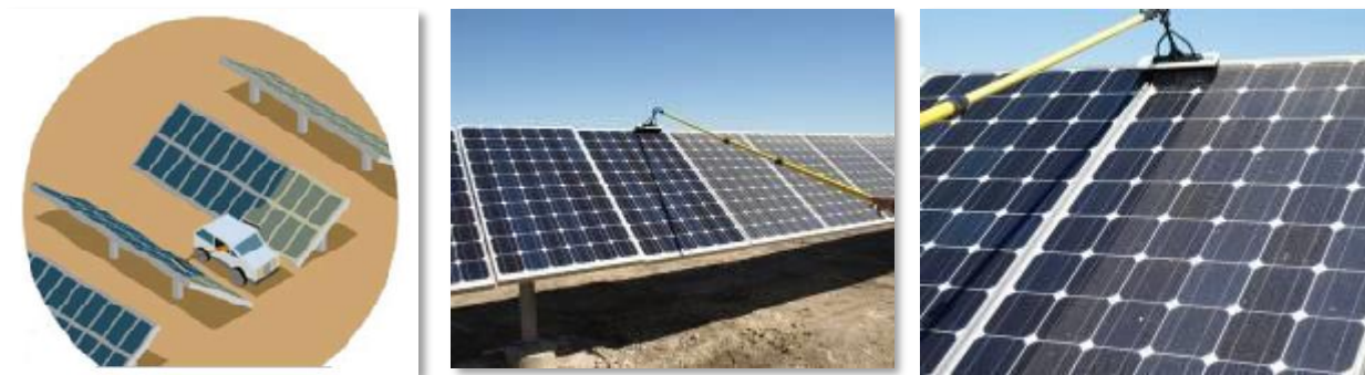
Figura II.15. Esquema de limpieza de los paneles fotovoltaicos
