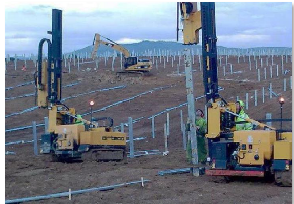
Figura II.12. Ejemplo de hincadoras hidráulicas.
