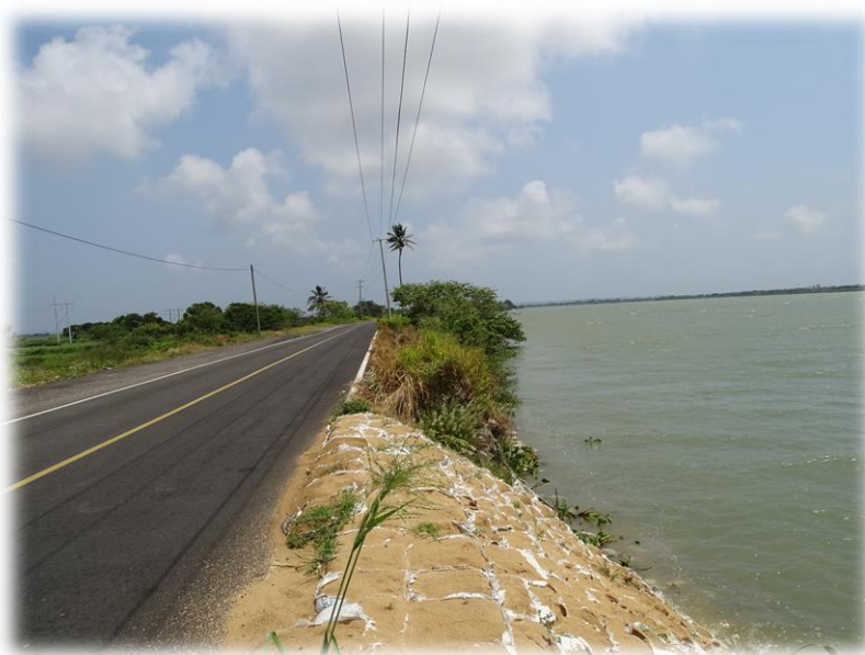
Imagen V. 19 Protección marginal contra la erosión.
