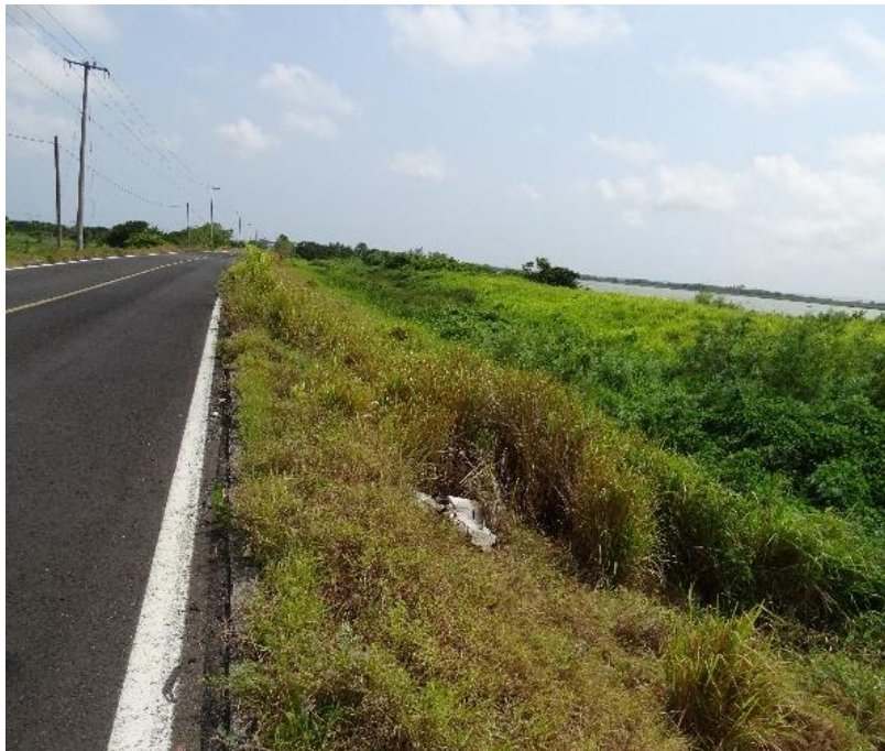
Imagen II. 13 Inicio de los trabajos propuestos
