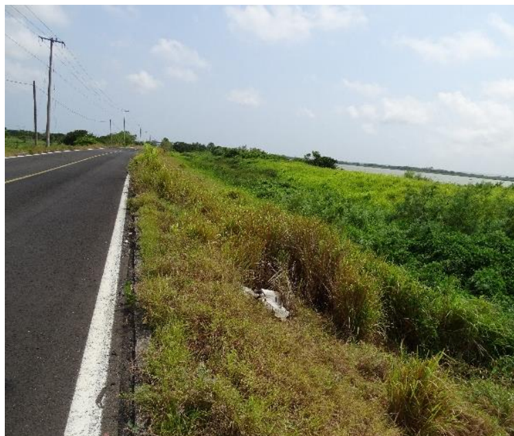
Fotografía I. 1 Inicio de los trabajos propuestos
