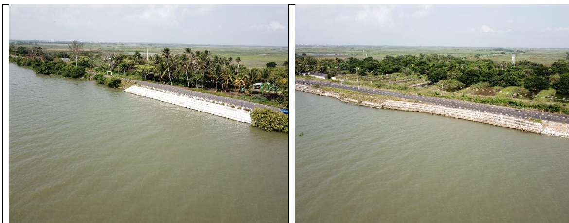
Imagen II. 10 obras de protección existentes
