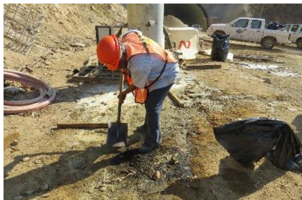
Figura 4. Retiro de suelo contaminado de forma manual (Ex situ).
