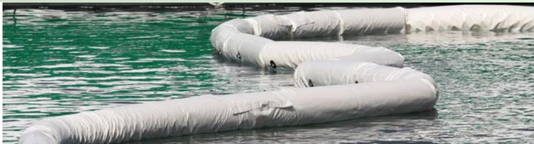
Figura 5. Contención del agua con barreras absorbentes con conpos de polipropileno.
