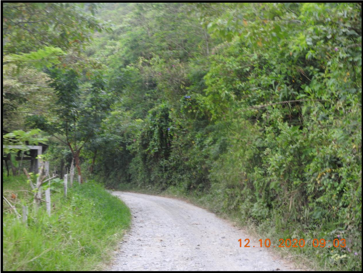
FIG. 2.10 IMÁGENES DONDE SE MUESTRA QUE SE TENDRA QUE ENSANCHAR UN POCO EL CAMINO YA QUE EN ESTE PUNTO MIDE 6M DE ANCHO
