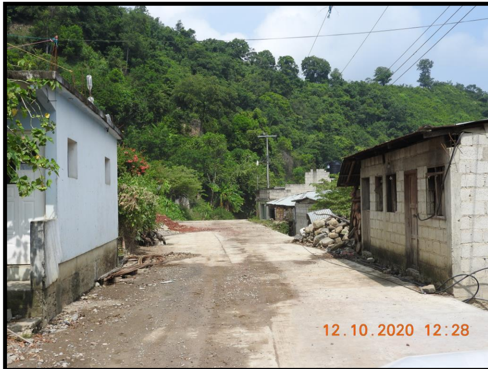
Vista actual de las condiciones del camino existente
