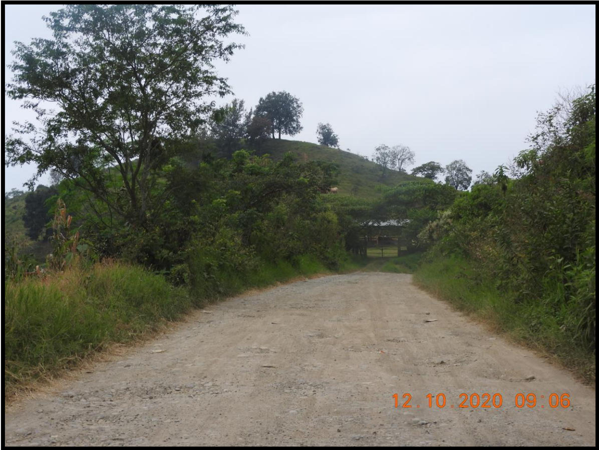
FIG.2.14 VISTA DEL CAMINO EXISTENTE QUE SE PRETENDE MODERNIZAR
