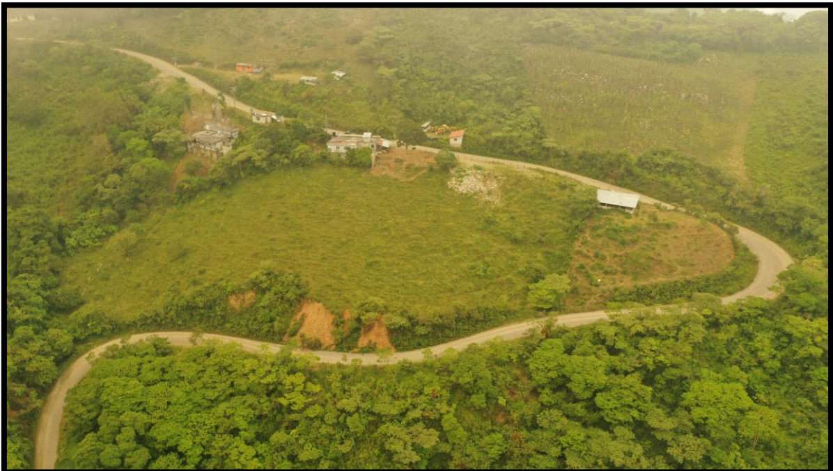
VISTA DEL CAMINO QUE SE PRETENDE MODERNIZAR
