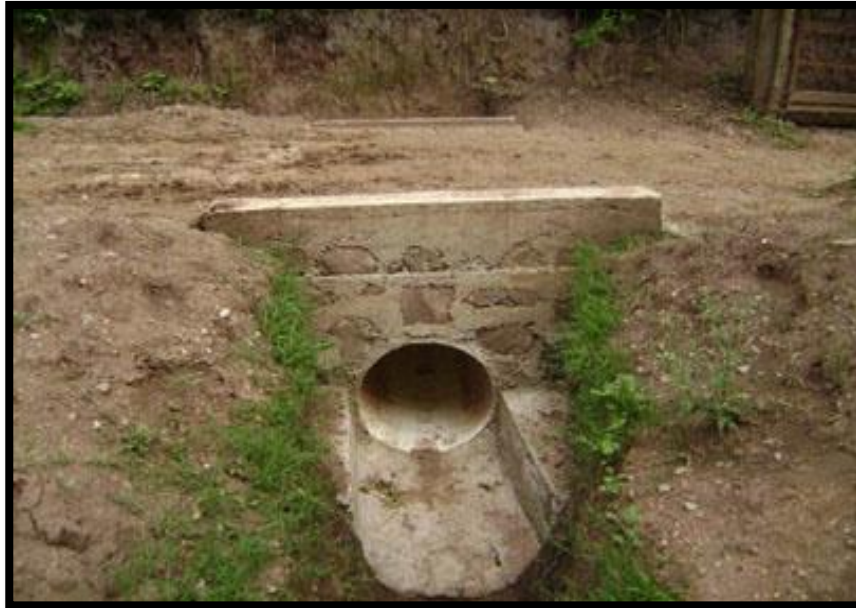
FIG.2.7 EJEMPLO DE OBRAS DE DRENAJE MENOR
