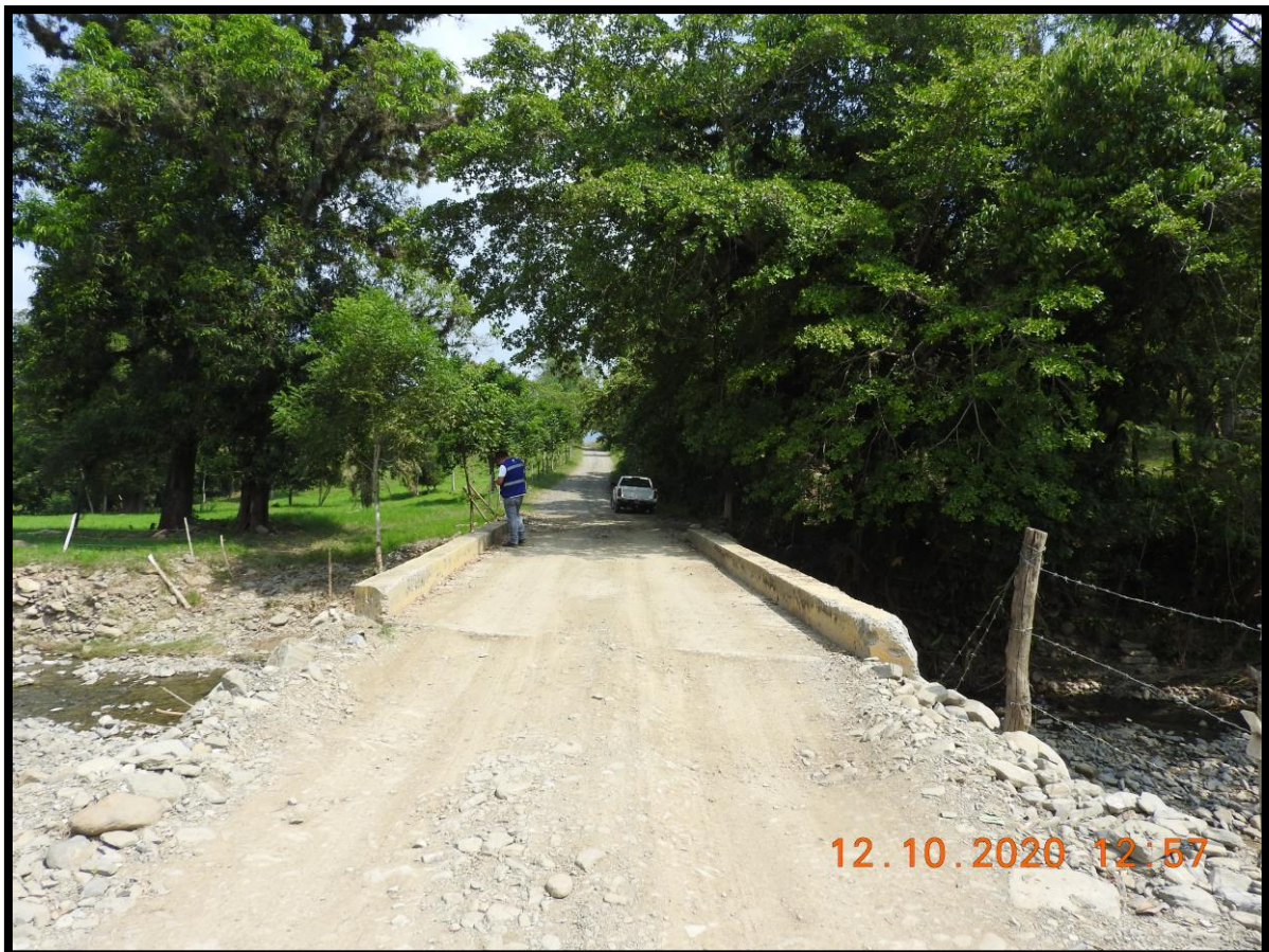
FIG. 2.4. IMAGEN DE LA OBRA DE DRENAGE MAYOR QUE NO ESTA INCLUIDA EN EL PRESENTE ESTUDIO
