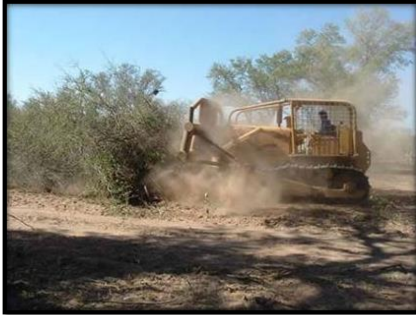
FIG.2.16 EJEMPLO DE UNA MAQUINA RETIRANDO LOS RESIDUOS VEGETALES
