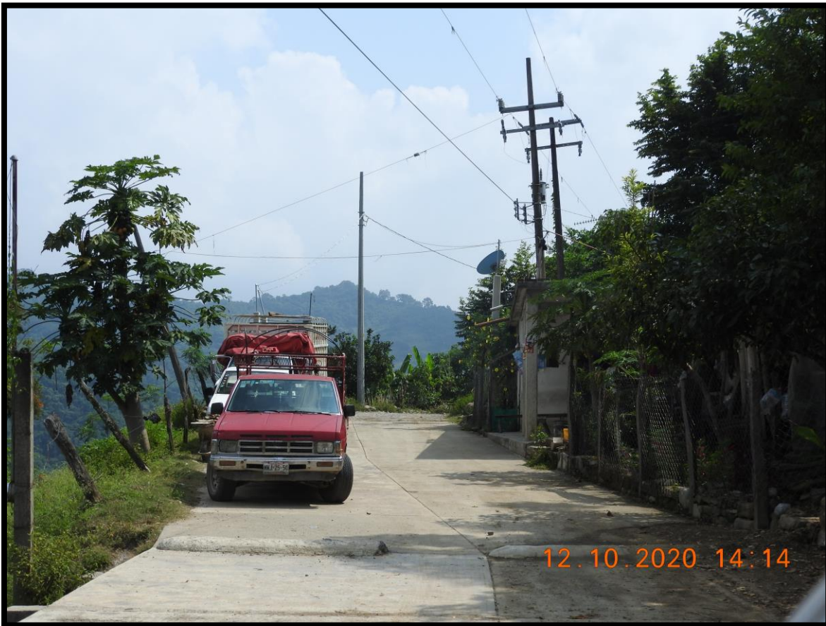
FIG. 2.7 IMAGEN DE LAS CONDICIONES DEL CAMINO ACTUAL Y DE LA ZONA
