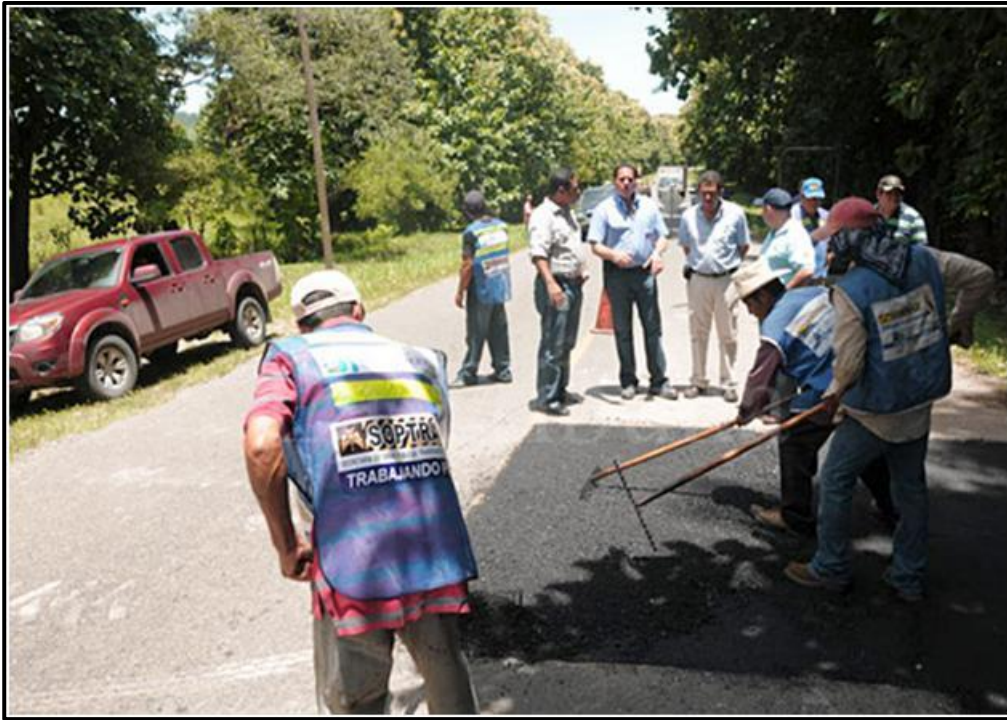
FIG.5.4 EJEMPLO DE BACHEO CON ASFALTO EN UNA CARRETERA
