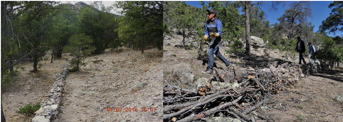
FIGURA VII.4 EJEMPLO DE BARRERAS DE PIEDRA ACOMODADA Y PRESAS DE RAMAS ACOMODADAS COMO ACCIONES DE CONSERVACIÓN Y RETENCIÓN DEL RECURSO SUELO
