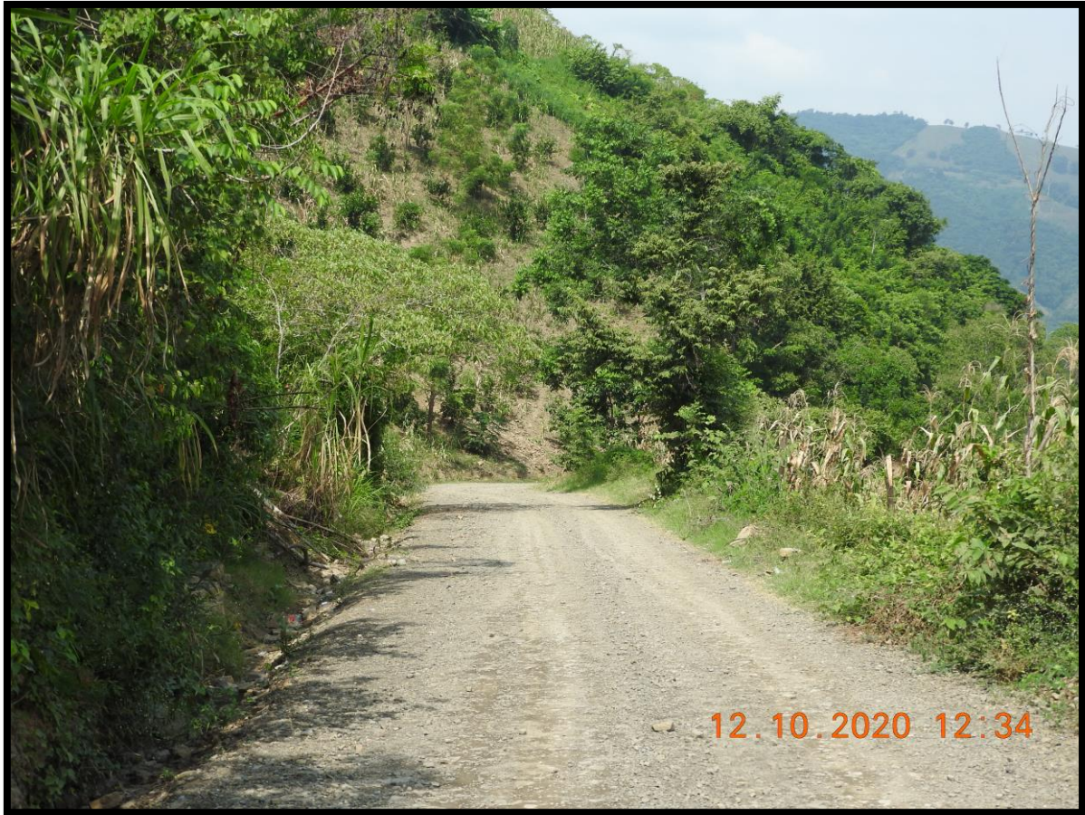
FIG. 2.6 IMAGEN DE LAS CONDICIONES DEL CAMINO ACTUAL Y DE LA ZONA
