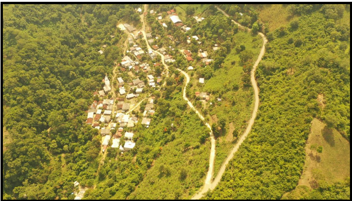
IMAGEN DEL INICIO DEL TRAMO CERCA DEL CRUCERO DE TOLTEPEC
