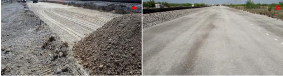
Figura 17. Imagen ilustrativa de la construcción de terracerías (A) y conformación final (B).
