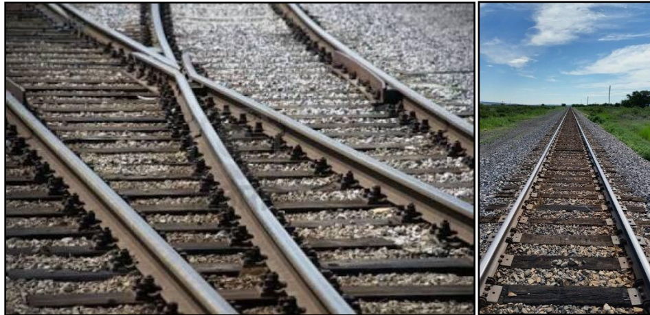
Figura 1. Fotografías ilustrativas de una interconexión ferroviaria
