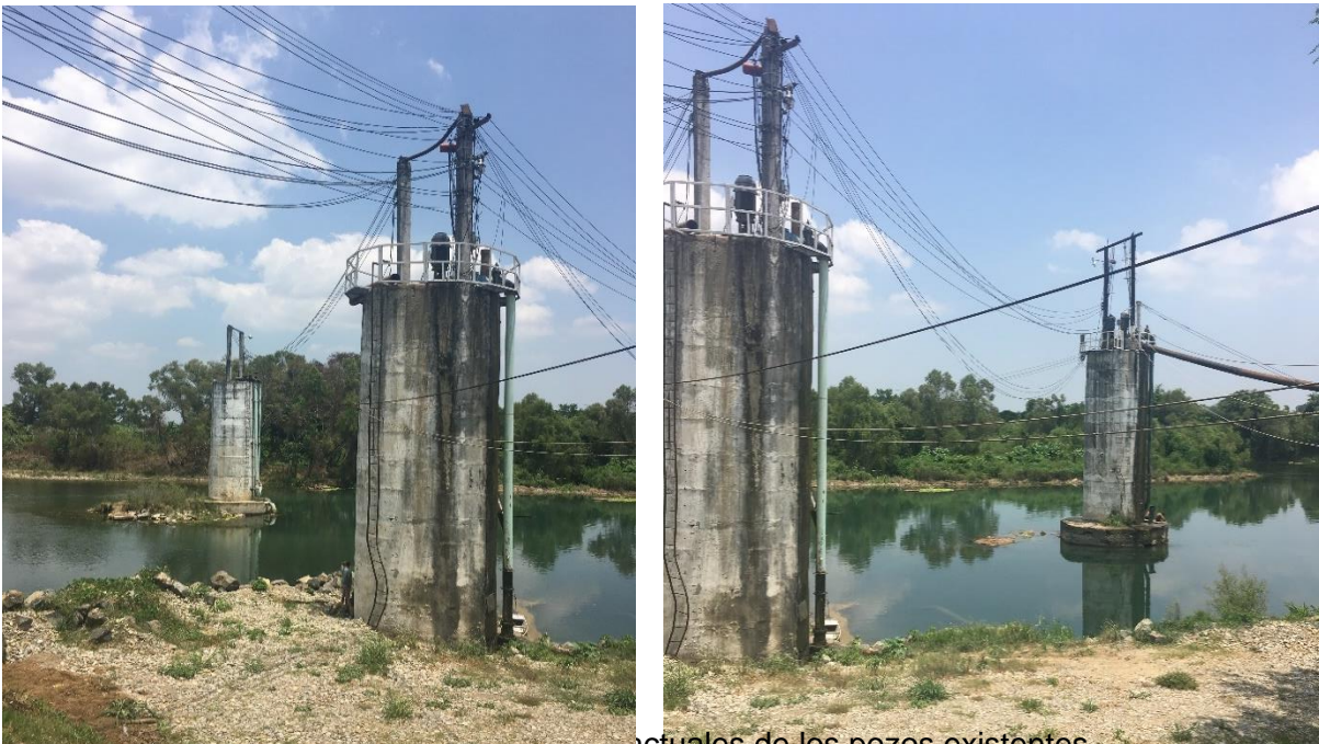
Fig. 2.12. Condiciones físicas actuales de los pozos existentes.
