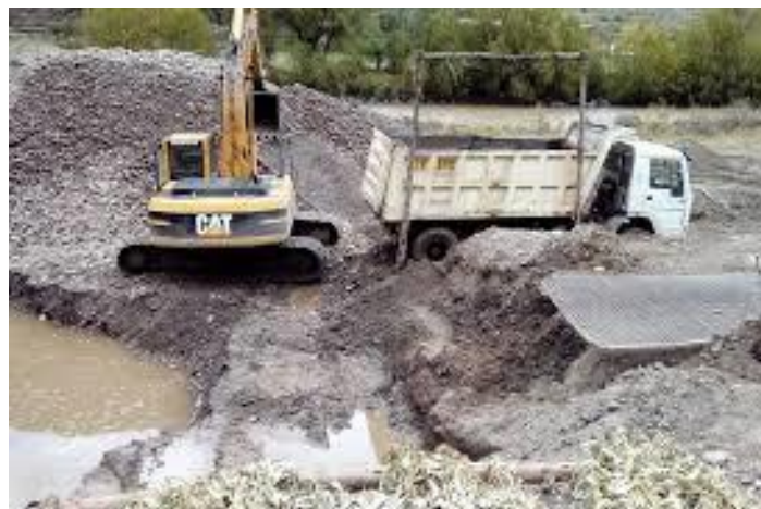
Fig. 2.27. Ejemplificación de extracción de material y acarreo.
