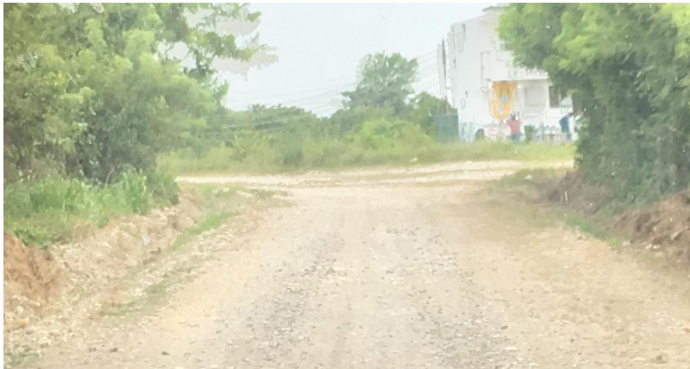
Fig. 4.13 Camino sobre el cual se instalará la línea de conducción.
