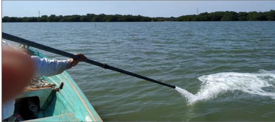
Figura II-19 Vista del chorro a presión para ejecución de los pozos de lavado en la laguna Pueblo Viejo.
