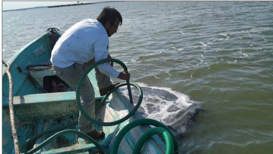
Figura II-21. Vista del tubo penetrando casi en su totalidad el fondo de la laguna.
