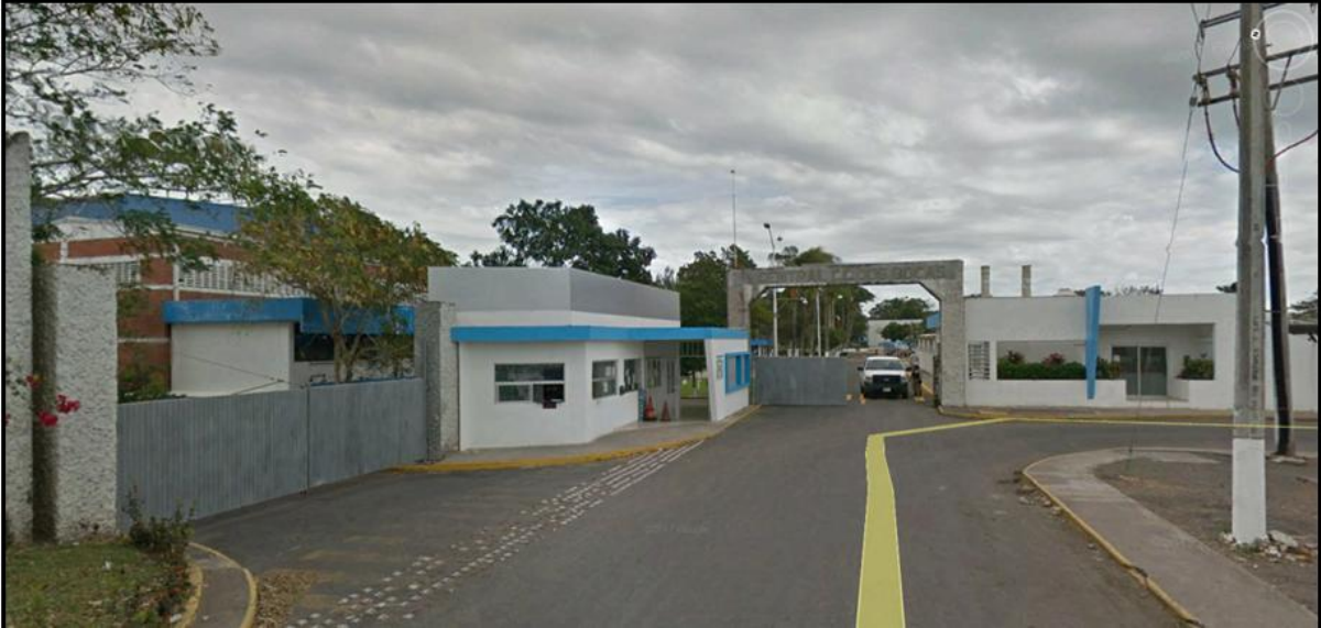
figura II.1-4 Entrada por Av. Bugambilias camino vecinal y estrecho (aprox. 7m) para llegar a la C.T. Dos Bocas II
