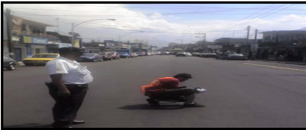
Figura 6. Señalización puntual del inicio del proyecto sobre la Avenida Miguel Hidalgo, a la altura de la estación 10+000.
