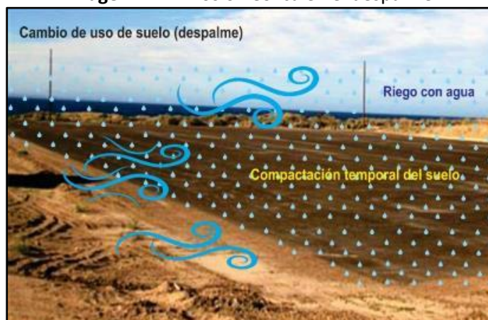
Imagen VI. 7. Erosión eólica en el despalme.
