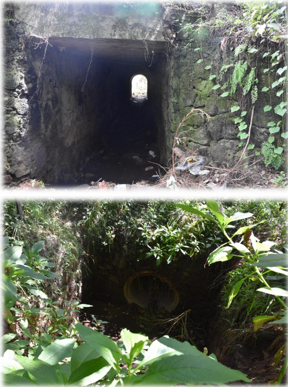
Fotografía V. 4. Obras de drenaje existentes usadas como paso de fauna.
