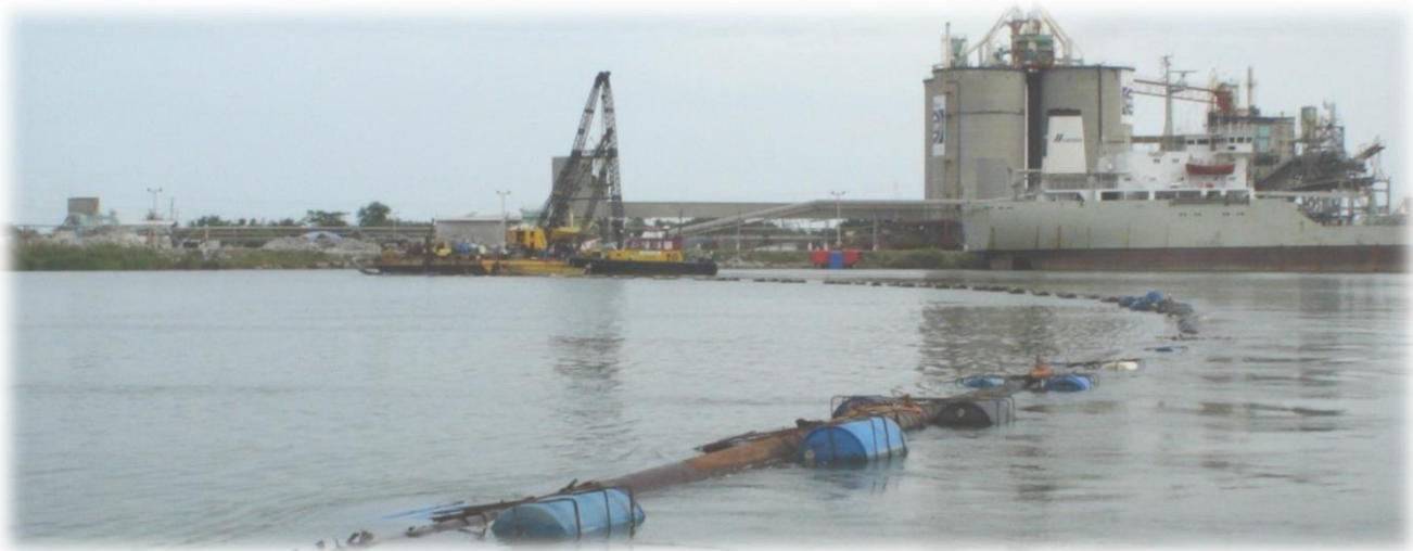
Figura 11. Bombeo de material producto de dragado a tierra firme.
