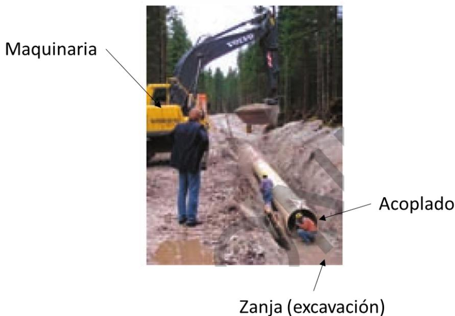
Figura 18.- Ejemplificación de las maniobras de colocación de tubería
