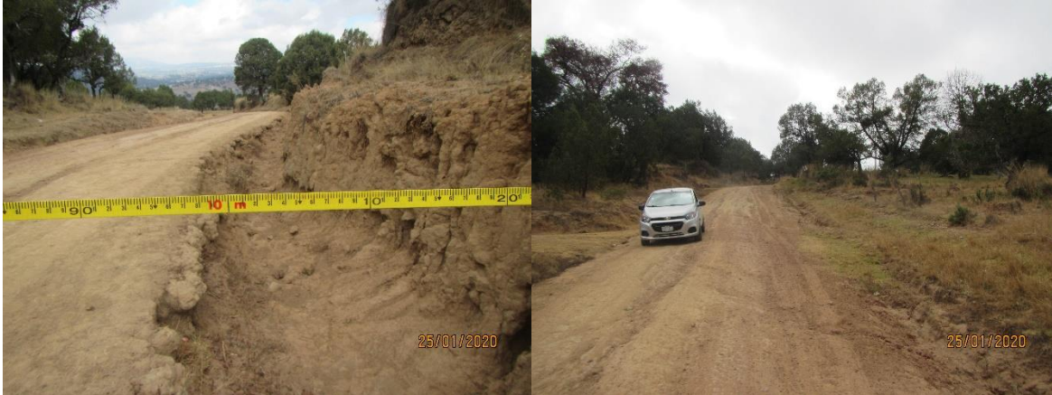
Figura I.5 Vista del camino de terracería existente que será modernizado
