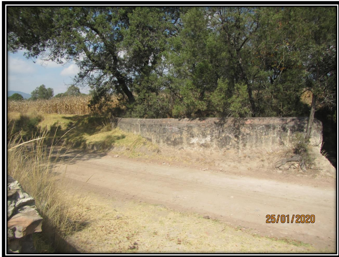
Figura II.14 Vista del primer puente existente
