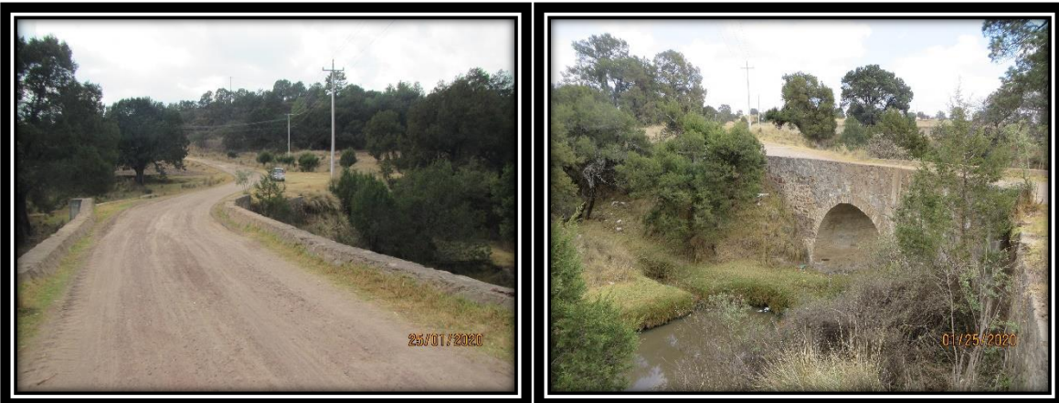
Figura II.16 Vista del tercer puente existente
