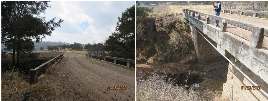
Figura III.15 Vista de un puente en el camino a modernizar
