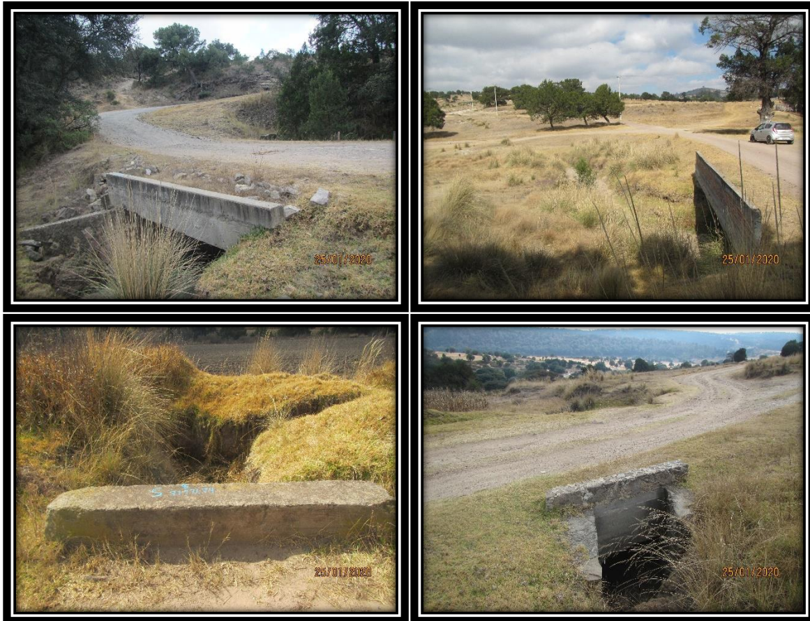
Figura II.29 Vista de algunas de las obras de drenaje menor existentes en el camino de terracería y que serán modernizadas
