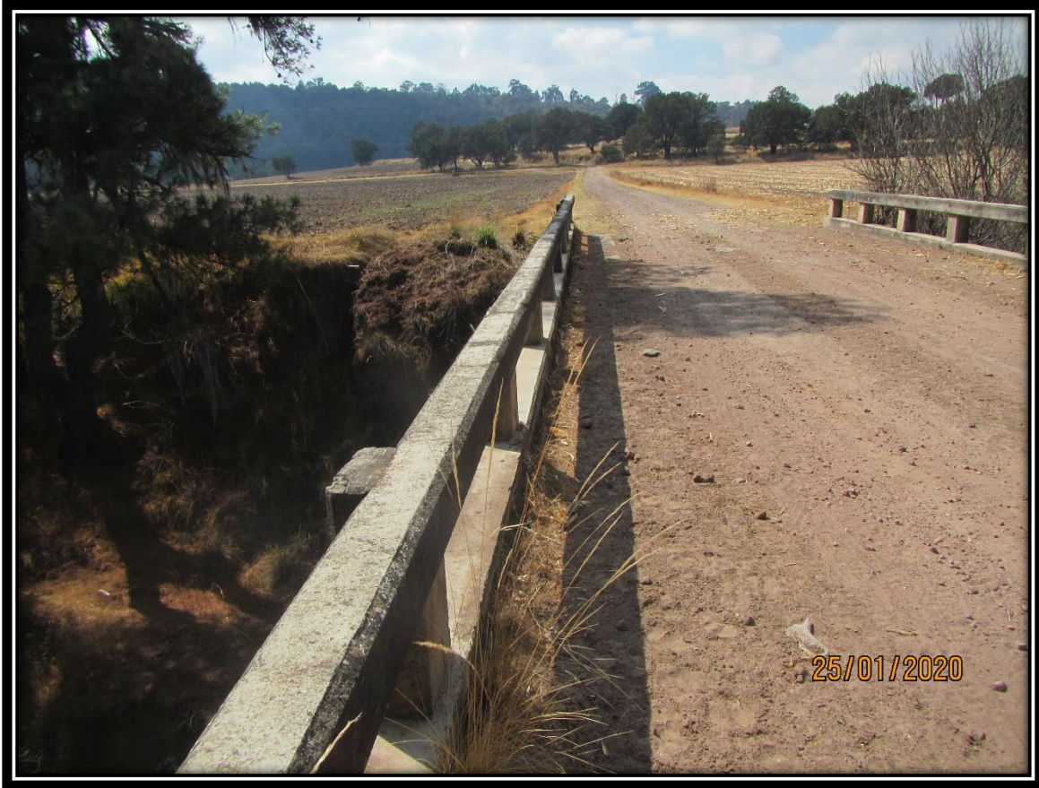
Figura II.15 Vista del segundo puente existente
