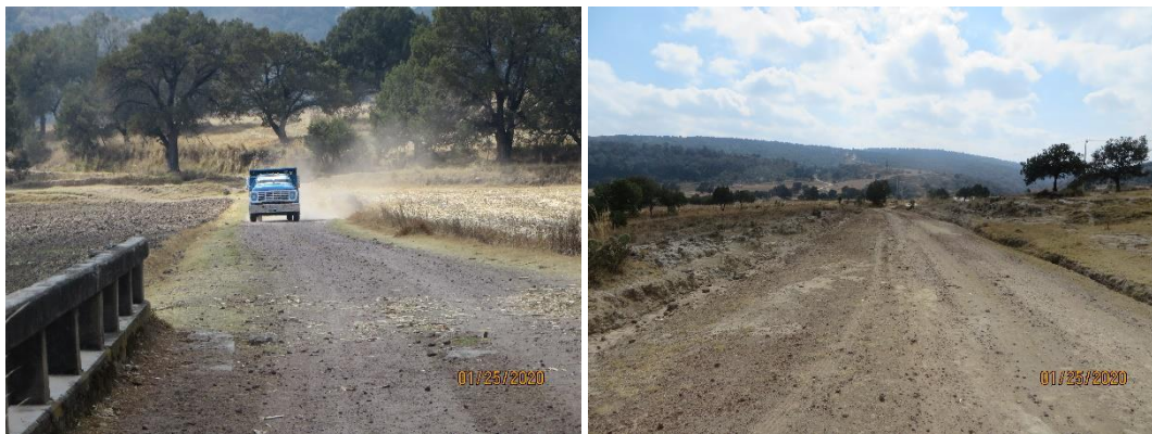
Figura III.3 Vista del camino de terracería actual que se pretende modernizar a una carretera tipo "C"
