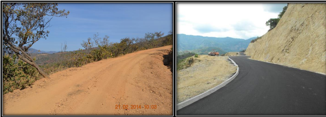
Figura V.1 Ejemplo de la transformación del paisaje por la modernización de un camino de terracería existente a una carretera tipo "C"
