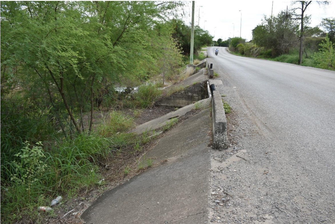
Vista desde arriba de la obra de drenaje existente desde el km 3+020.
