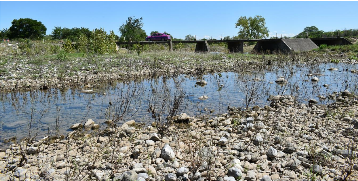
Vista aguas arriba de la obra, lado izquierdo del trazo donde se realizarán las ampliaciones.
