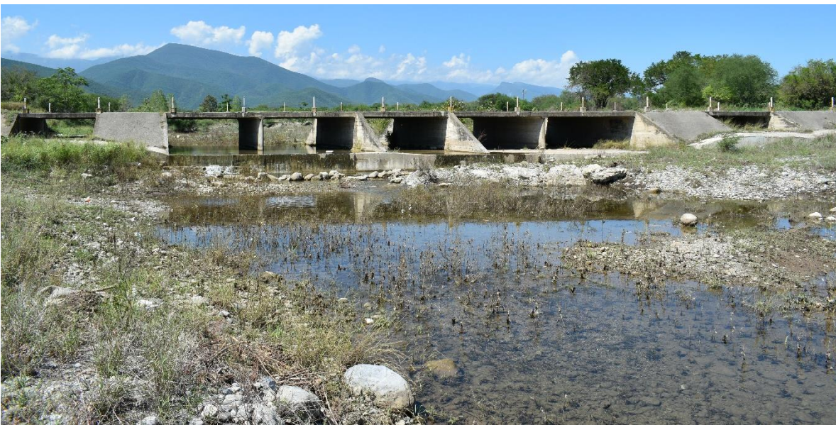
Fotografía aguas abajo del lado derecho al eje central.
