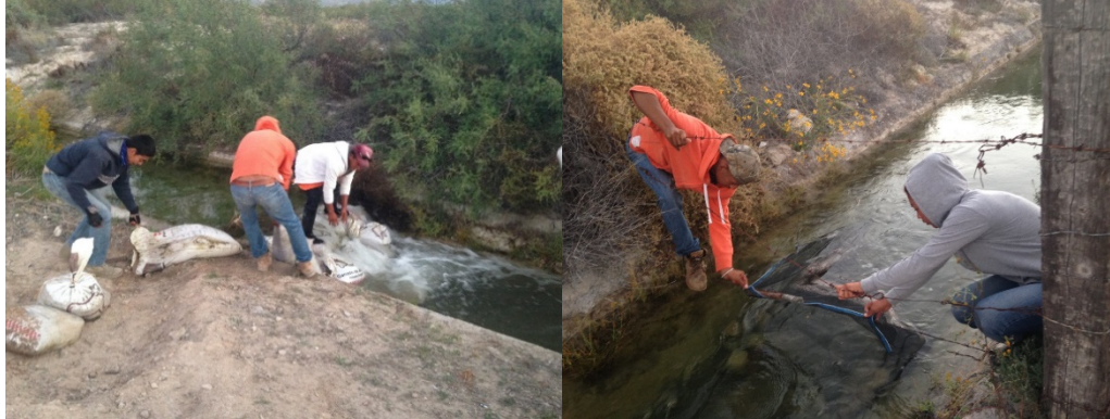
Imagen 29. Retiro de los materiales utilizados.
