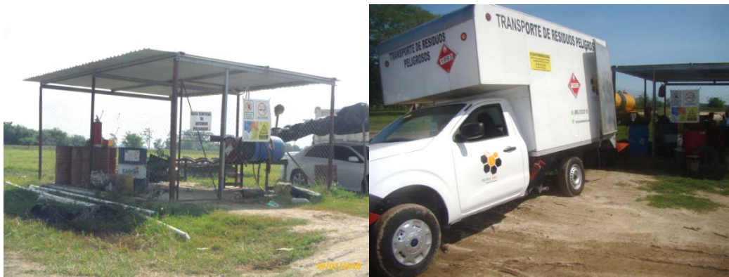
Imagen 6. Almacén temporal de residuos peligrosos habilitado por las Contratistas
