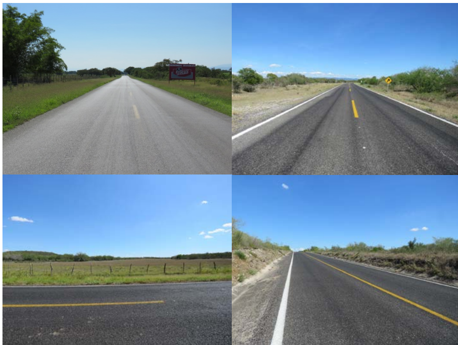
Imagen 68. Vista de las condiciones del camino, se observa una calidad homogénea.
