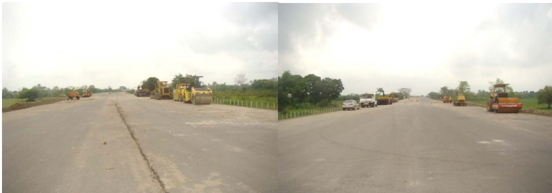
Imagen 11. Se muestran en las imágenes los vehículos y maquinaria se mantienen en todo momento sobre el cuerpo carretero en construcción.
