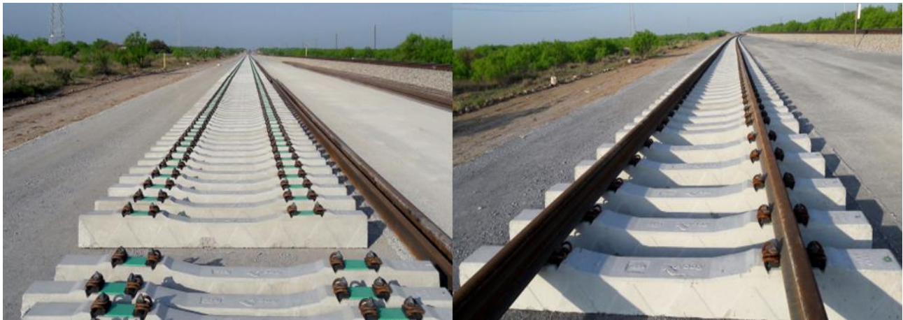
Figura 6. Ejemplo de tendido de la vía férrea
