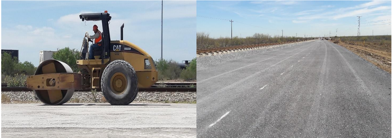
Figura 5. Ejemplo de compactación y nivelación de la capa de sub-balasto.
