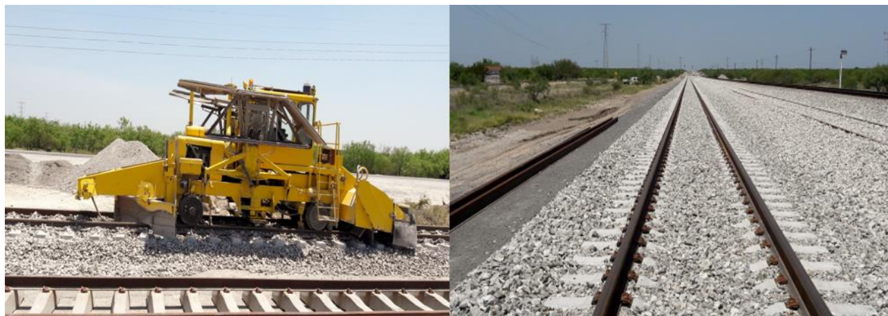
Figura 9. Conformación de perfil mediante maquina reguladora de balasto.
