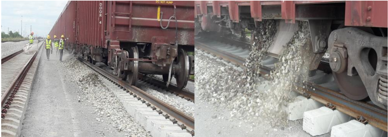
Figura 7. Distribución de balasto mediante góndolas.
