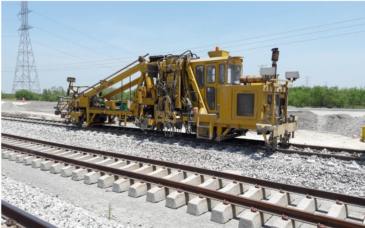
Figura 8. Alineamiento y nivelación de vía férrea mediante maquina calzadora.
