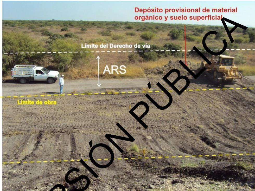
Figura VI.1 Ejemplo ilustrativo del manejo y disposición inicial del suelo. El suelo "despalme" con vegetación y materia orgánica se removerá con maquinaria pesada y se dispondrá a manera de "depósito provisional" en los extremos del derecho de vía. Una vez construida la obra, la maquinaria deberá esparcir homogéneamente el depósito sobre las áreas de restauración de suelo (ARS).
