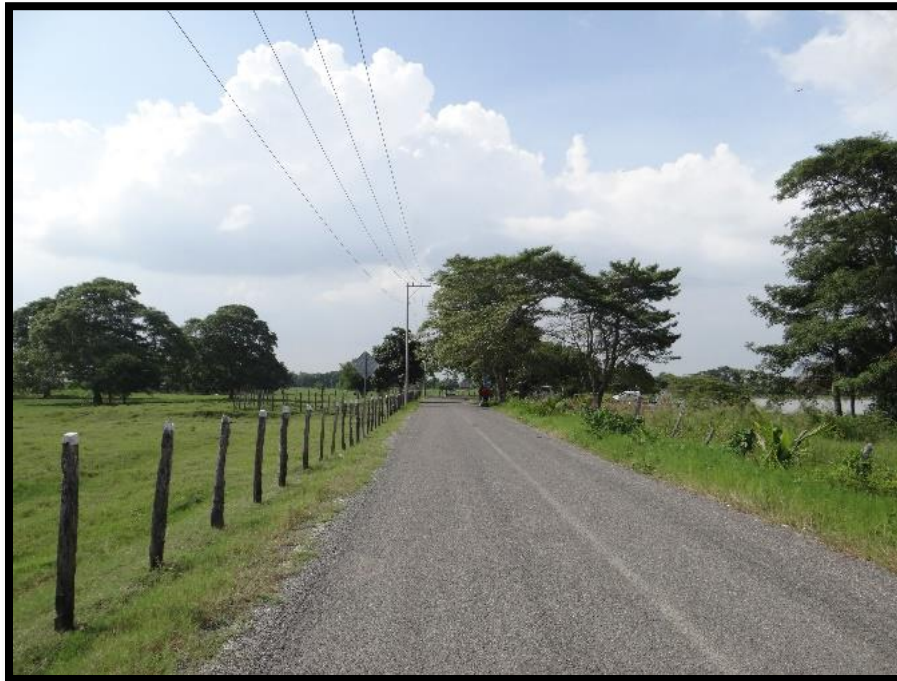
Fotografía II. 2. Final del proyecto
