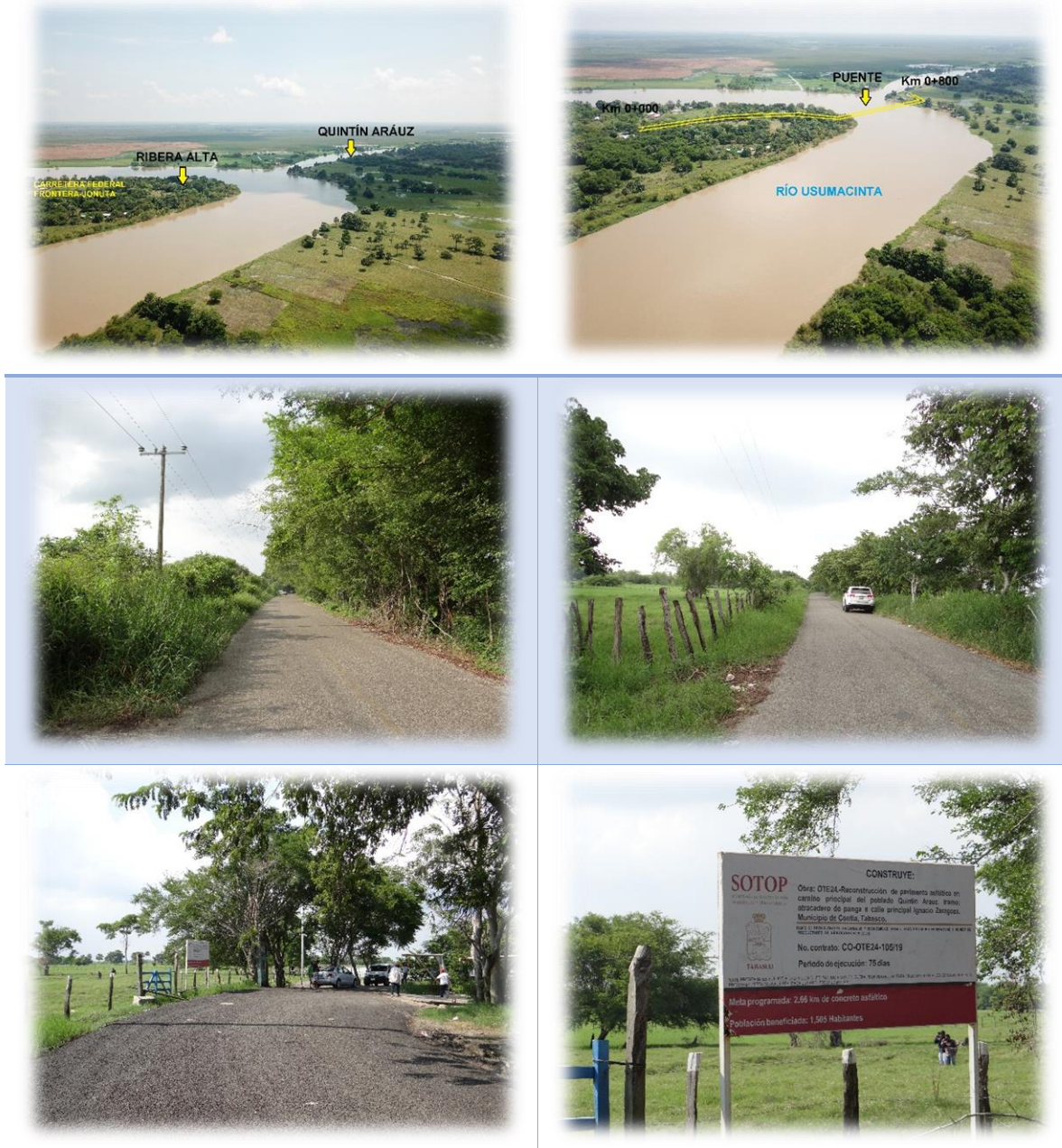
Imagen V. 15. Vista aérea del Río Usumacinta y las futuras conexiones con las carreteras correspondientes.
