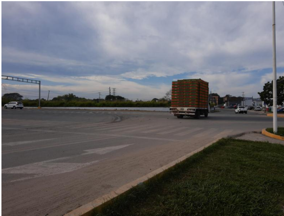
Fig.30. Superficie donde se realizará la obra desprovista de vegetación.
