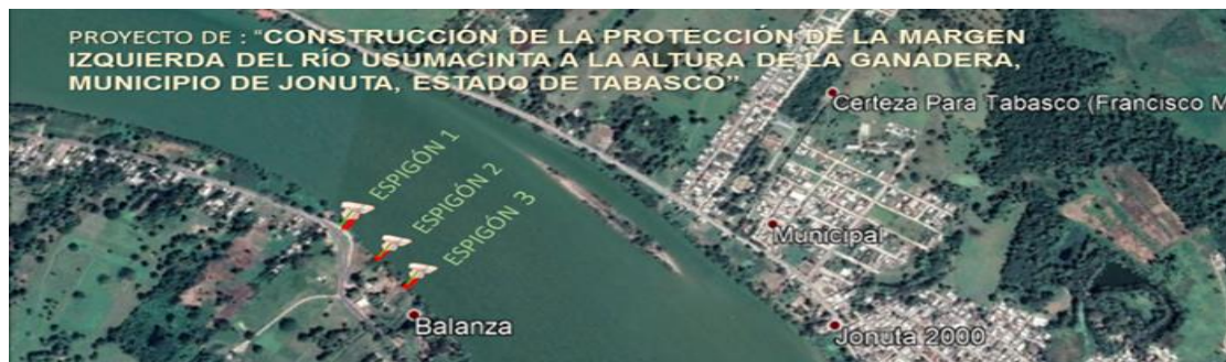
Ilustración 5. Construcción de espigones y Poligonal de apoyo
