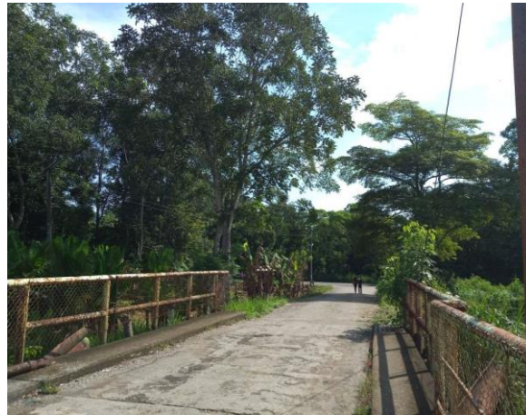
Vías de comunicación tipo puente, presente en la zona en la cual se pretende desarrollar el proyecto. Puede observarse la presencia de individuos Piche ( Enterolobium cyclocarpum ).
