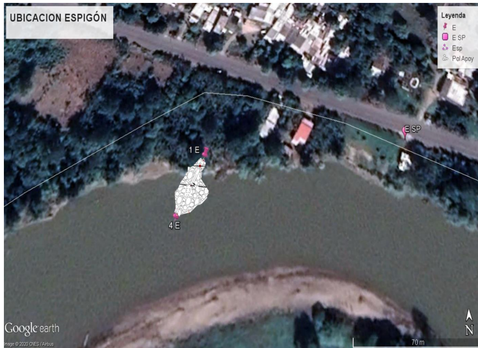
Ilustración 8. Ubicación del espigón sobre la margen derecha del río la Sierra
