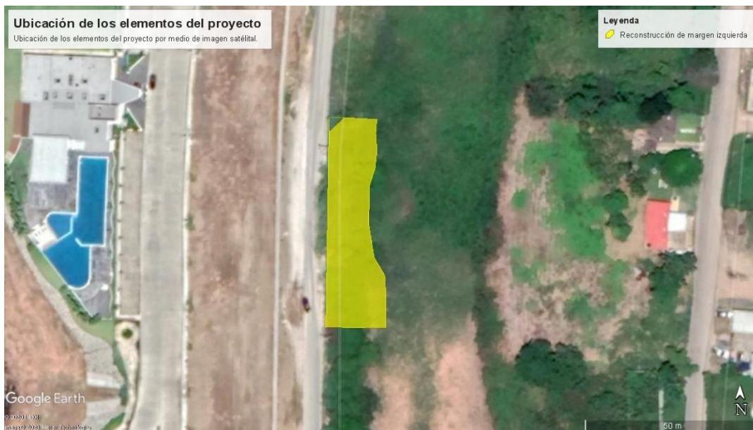
Ilustración 3. Ubicación de la reconstrucción de la margen izquierda del Río Viejo Mezcalapa, a la altura de la localidad Plutarco Elías Calles.
