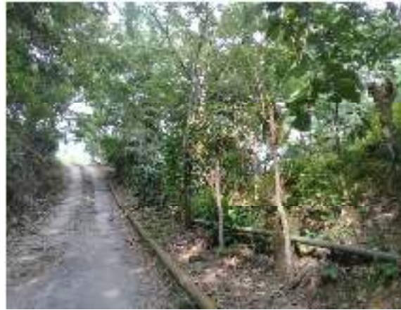
Figura 34. Ducto de agua en el km 2+200 el cual se reubicara en las áreas que presente afectación.
