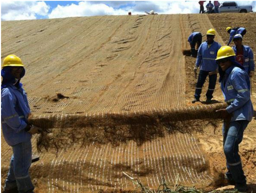
Figura 9. Ejemplo de colocación de biomantas en taludes.
