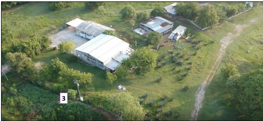
Figura 66. Vista de las condiciones actuales al norte del entronque tipo “T”
