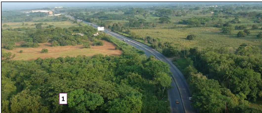
Figura 64. Vista de la carretera Federal México 186 en dirección hacia Villahermosa
