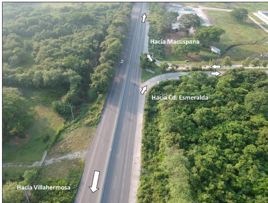
Figura 4. Vista de las condiciones actuales del entronque tipo “T” que conecta hacia el nuevo desarrollo de Cd. Esmeralda
