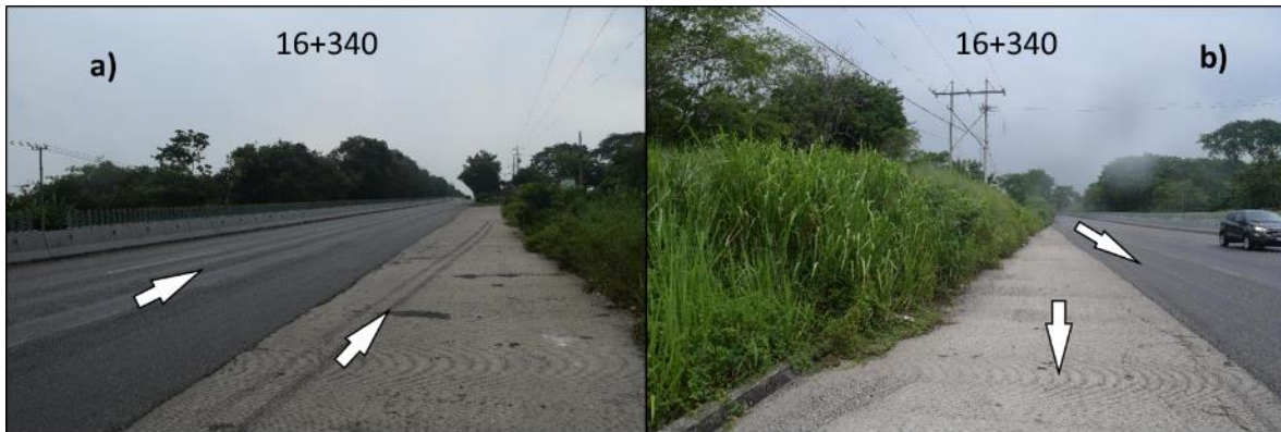
Figura 26. Vista de las condiciones actuales de la Carretera Villahermosa- Macuspana, donde la figura a) se muestra en dirección hacia Macuspana, donde el camino se bifurca para formar el Eje 50 existente que conduce hacia Cd. Esmeralda, mientras que la figura b) muestra el cuerpo de la Carretera Villahermosa- Macuspana proveniente de Villahermosa.
