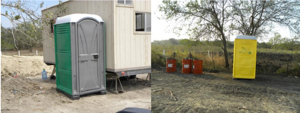
Figura 7. Colocación de sanitarios portátiles en los frentes de trabajo.
