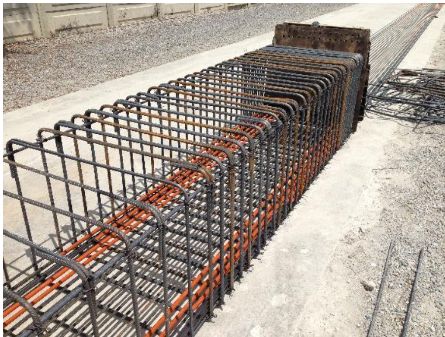
Figura 77. Armado de traveses prefabricados
