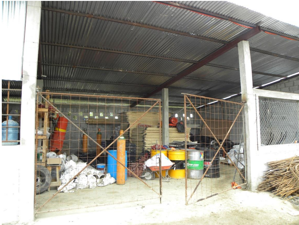
Figura 6. Ejemplo de almacén temporal de residuos peligrosos y de manejo especial.
