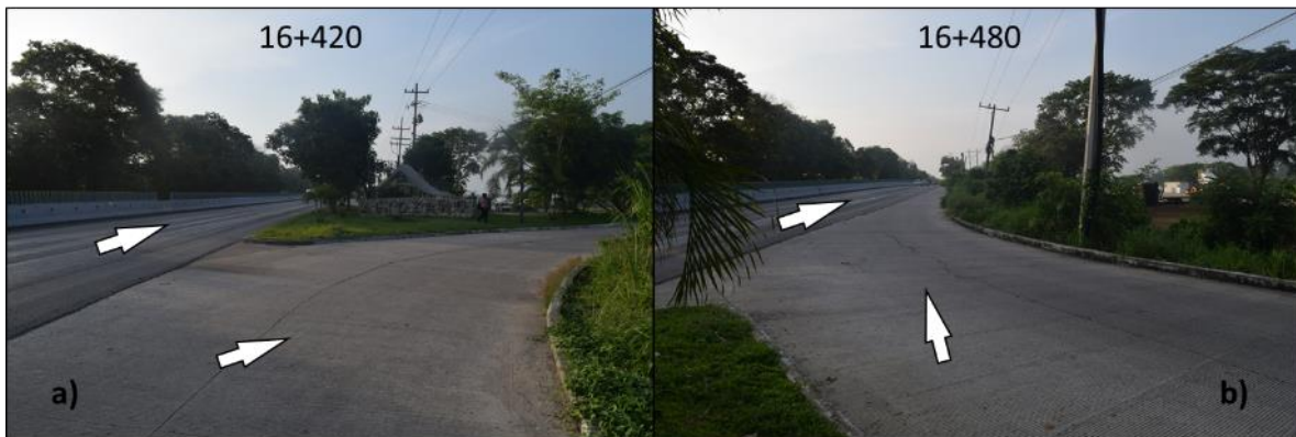
Figura 29. Vista de las características actuales del entronque, donde la figura a) muestra al Eje 50 con dirección hacia Cd. Esmeralda, mientras que la figura b) muestra al Eje 60 en su unión con la carretera Villahermosa- Macuspana, con dirección hacia esta última.
