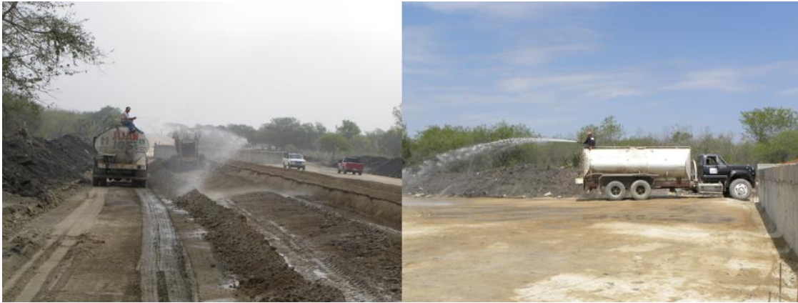
Figura 10. Riego de la superficie para evitar el levantamiento de polvo
