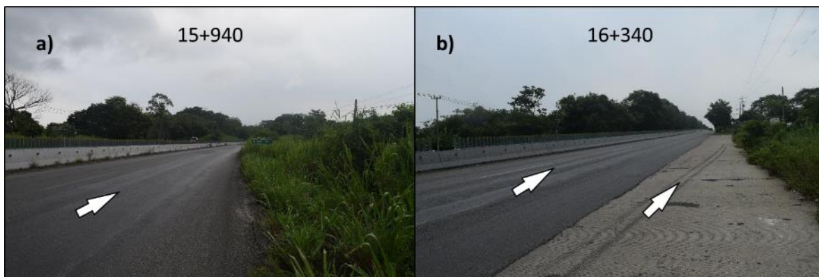
Figura 25. Vista de las características actuales de la Carretera Villahermosa- Macuspana, donde la figura a) muestra donde se compone de un único cuerpo de 3 carriles, mientras que la figura b) muestra la formación del Eje 50 existente, con dirección hacia Cd. Esmeralda.
