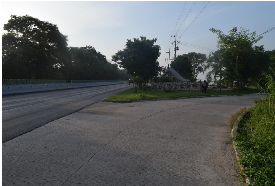
Figura 51. Vista de la carretera Villahermosa-Macuspana y calle de acceso
