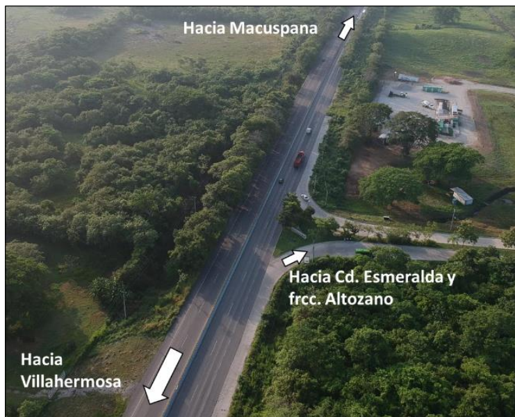
Figura 24. Vista aérea de las condiciones actuales del entronque hacia Cd. Esmeralda y Fraccionamiento Altozano
