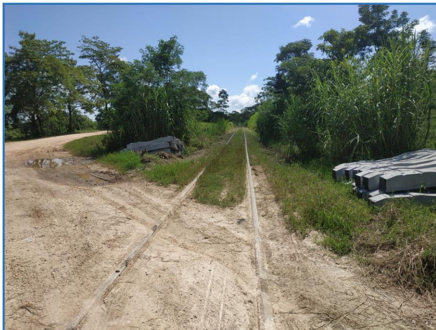
Foto 3. Cruce del camino con vía férrea de Tren
