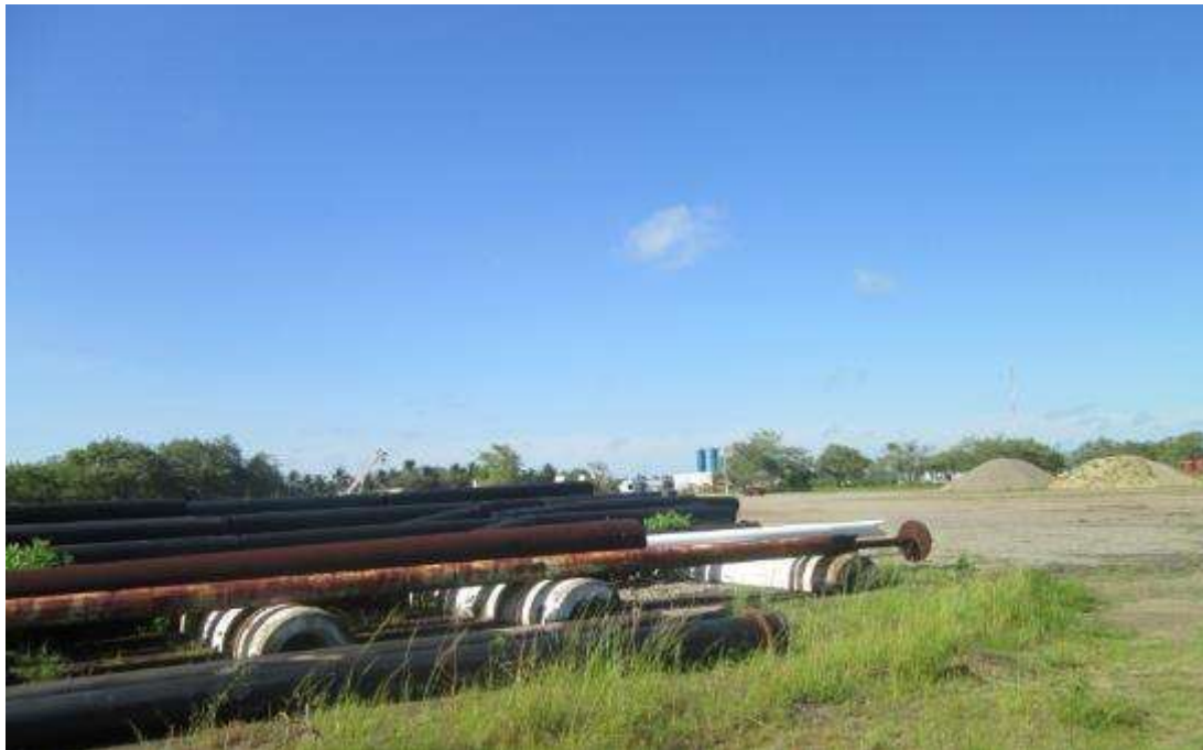
Fig.95. Plataformas a las que se le realizara las actividades de mantenimiento y rehabilitación.
