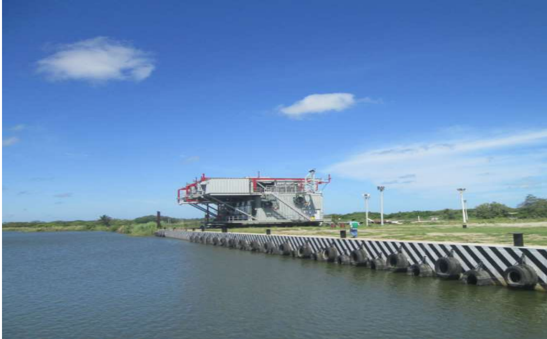
Fig.105. Área de la Corredera 1 a la que se le realizara las actividades de mantenimiento y rehabilitación.
