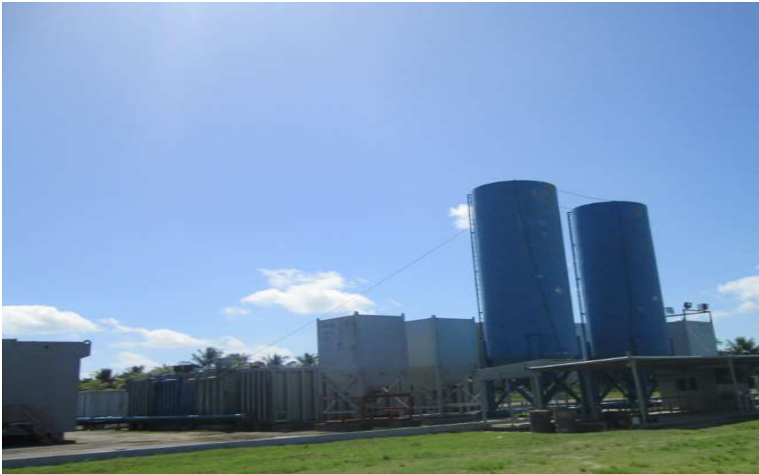
Fig.108. Plataforma de lodos a la que se le realizara las actividades de mantenimiento y rehabilitación.
