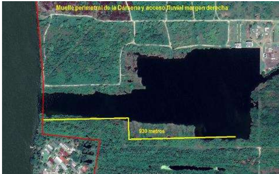
Fig.71. Longitud total del muelle perimetral de la margen derecha.
