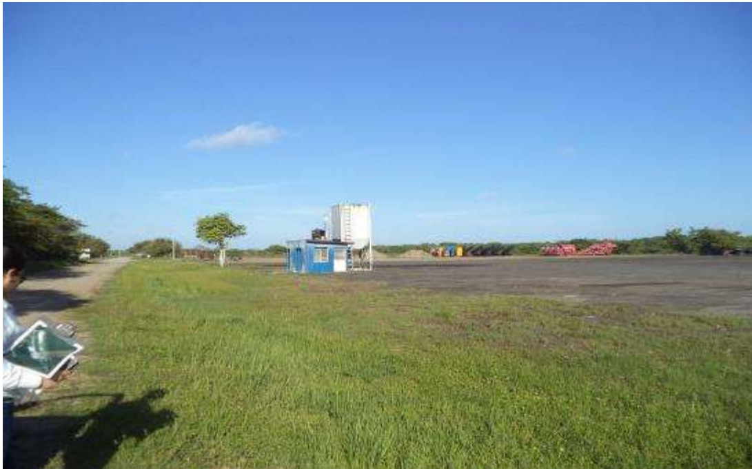
Fig.97. Plataformas a las que se le realizara las actividades de mantenimiento y rehabilitación.
