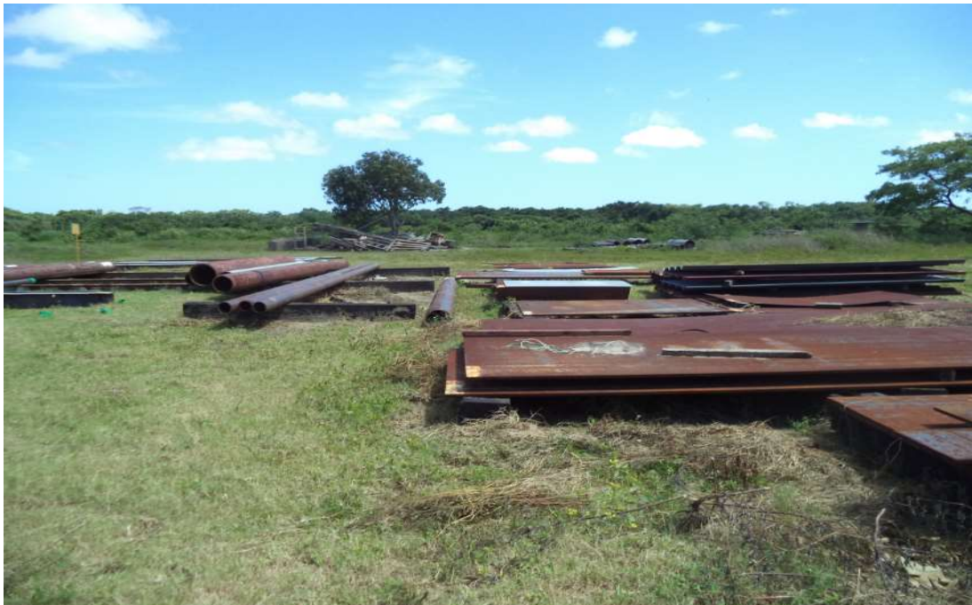
Fig.103. Área de Armado y Soldadura las que se le realizara las actividades de mantenimiento y rehabilitación.
