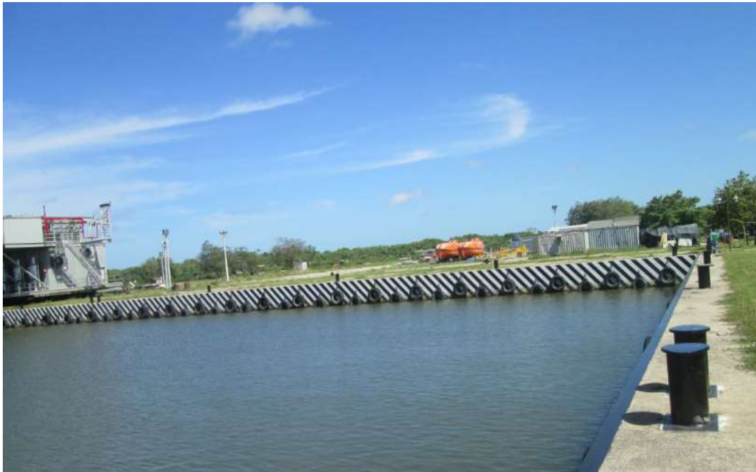
Fig.114. Muelle marginal de la dársena se le realizará las actividades de mantenimiento y rehabilitación.
