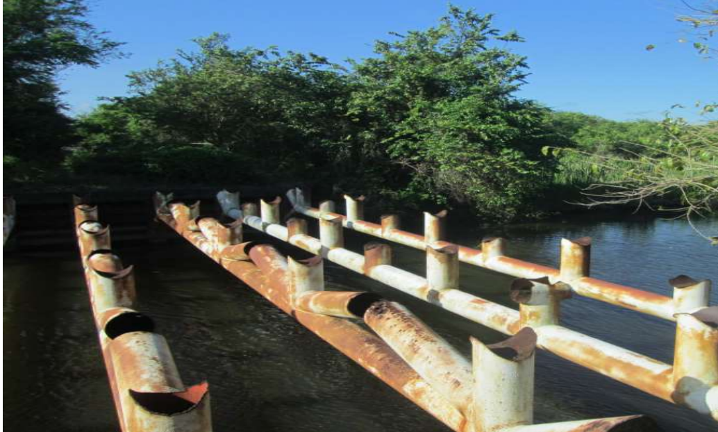
Fig.118. Puente tubular se le realizara las actividades de mantenimiento y rehabilitación.
