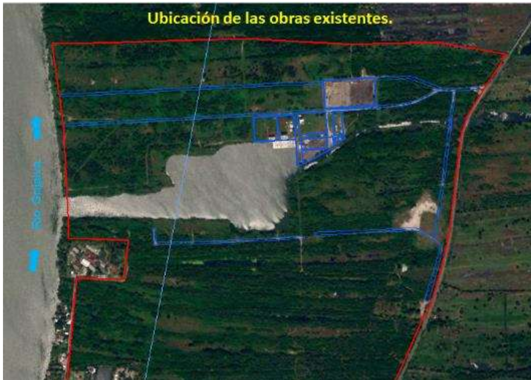
Fig.6.Obras existentes como parte del proyecto.
