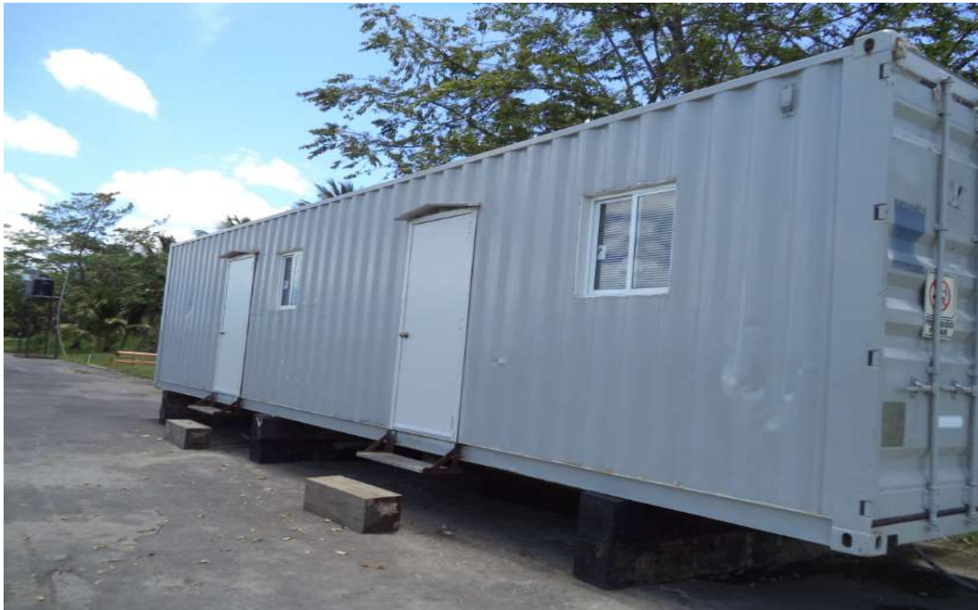
Fig.113. Oficina, almacén a la que se le realizara las actividades de mantenimiento y rehabilitación.
