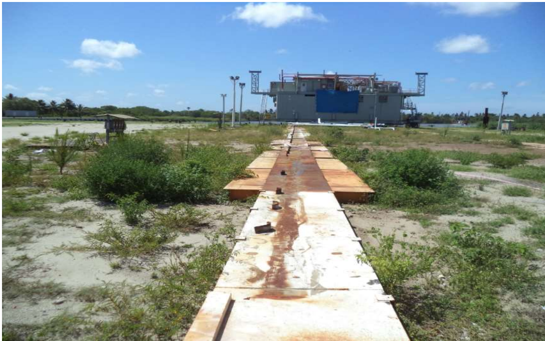
Fig.104. Área de la Corredera 1 a la que se le realizara las actividades de mantenimiento y rehabilitación.
