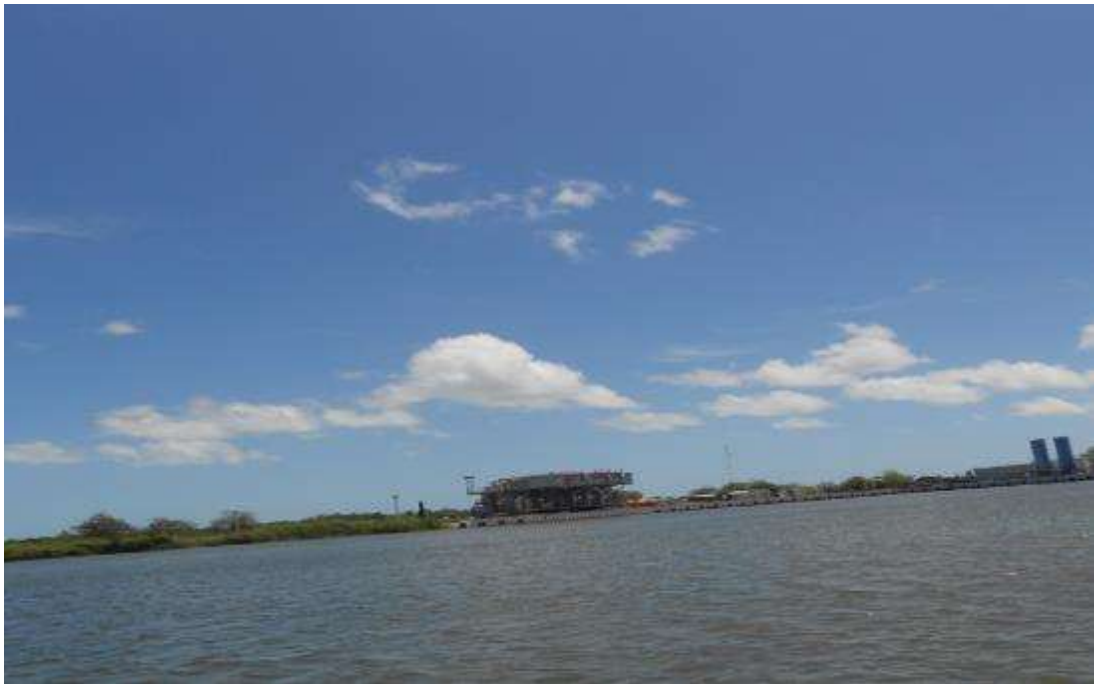
Fig.70. Superficie donde se construirá el muelle perimetral izquierdo.
