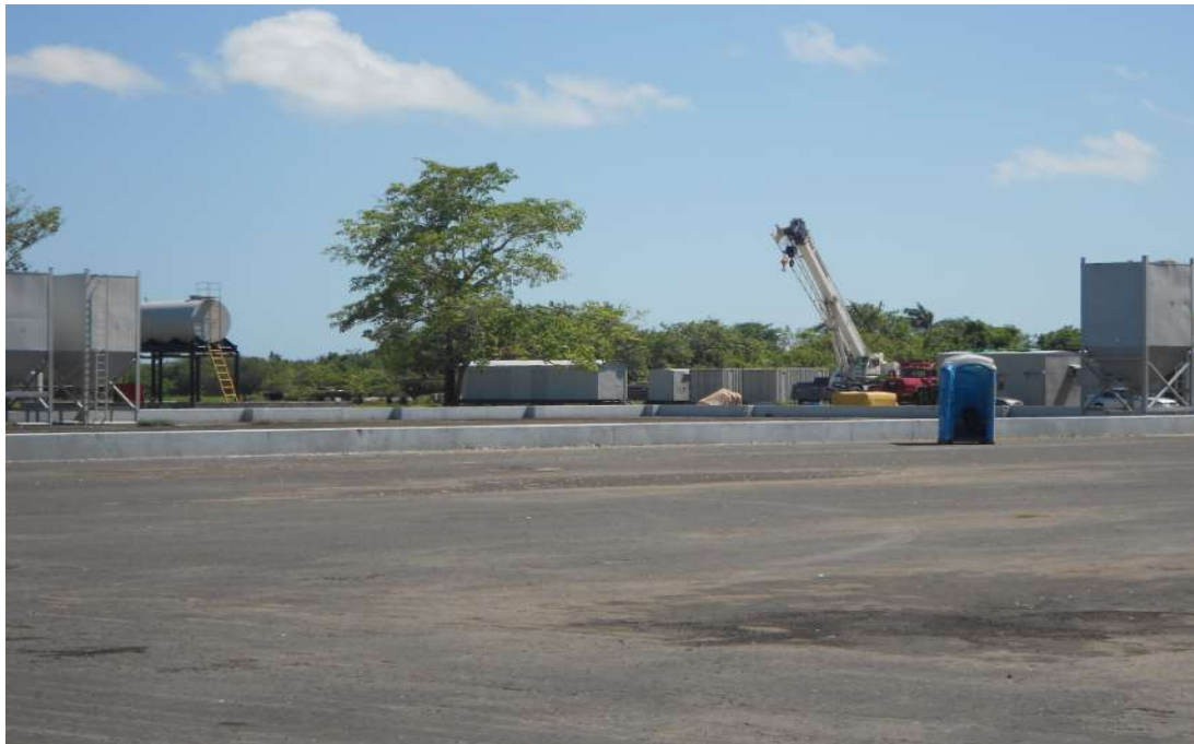
Fig.110. Plataforma de lodos a la que se le realizara las actividades de mantenimiento y rehabilitación.
