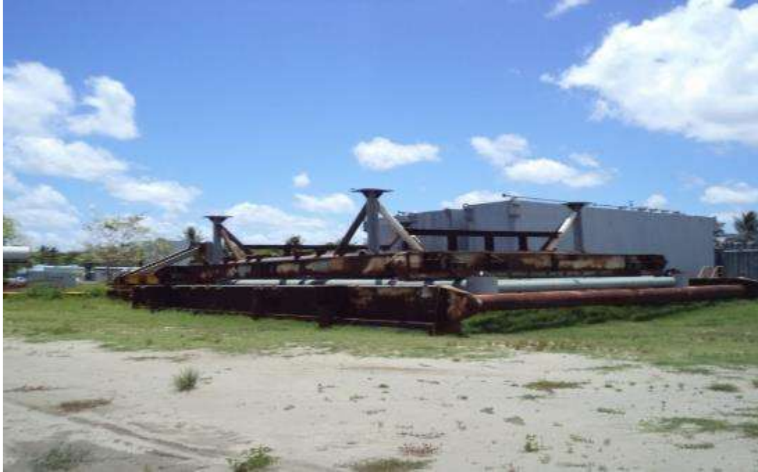
Fig.100. Área de Prefabricados a las que se le realizara las actividades de mantenimiento y rehabilitación.
