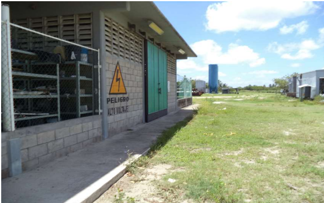
Fig.101. Área de Armado y Soldadura las que se le realizara las actividades de mantenimiento y rehabilitación.
