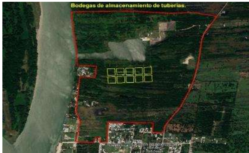
Fig.49. Bodegas de almacenamiento de tuberías.
