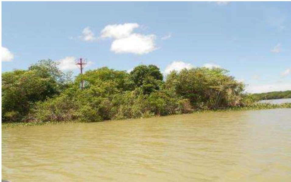
Fig.72. Superficie donde se construirá el muelle perimetral derecha.
