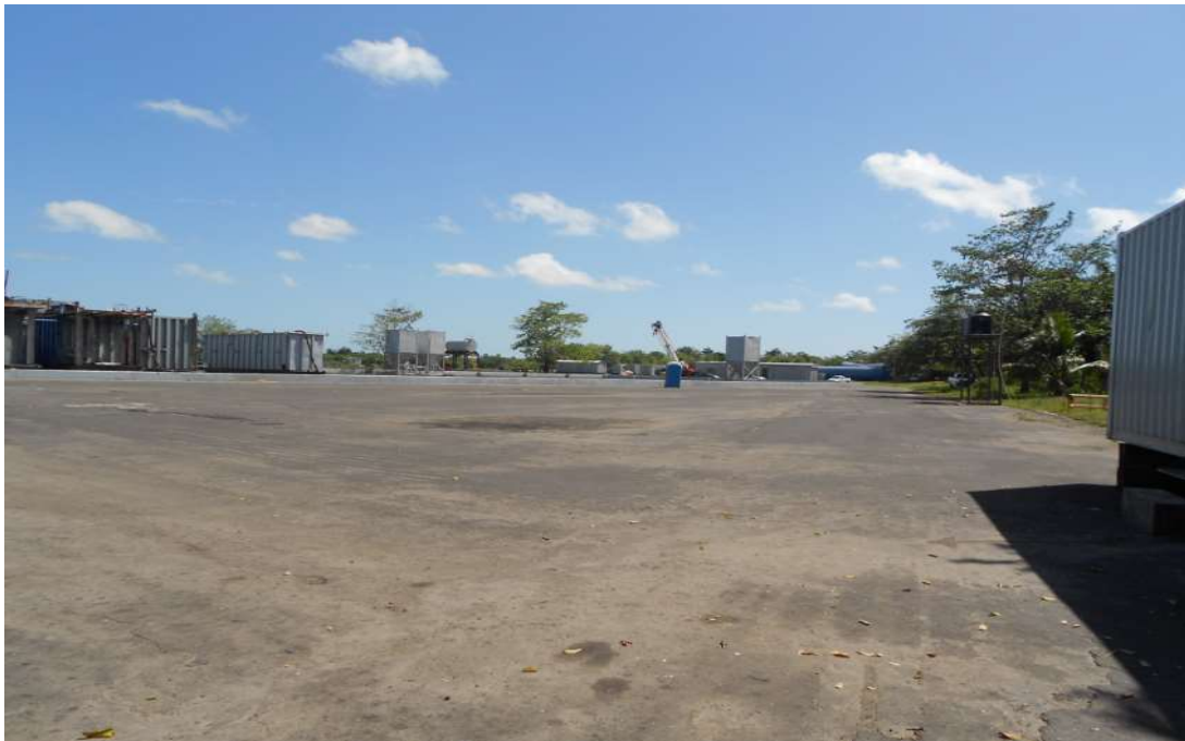
Fig.112. Área para maniobras de vehículos de la Plataforma de lodos a la que se le realizara las actividades de mantenimiento y rehabilitación.
