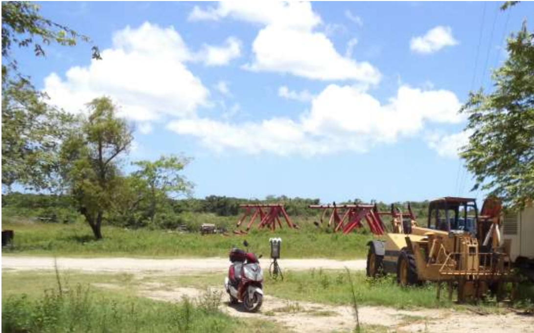
Fig.102. Área de Armado y Soldadura las que se le realizara las actividades de mantenimiento y rehabilitación.
