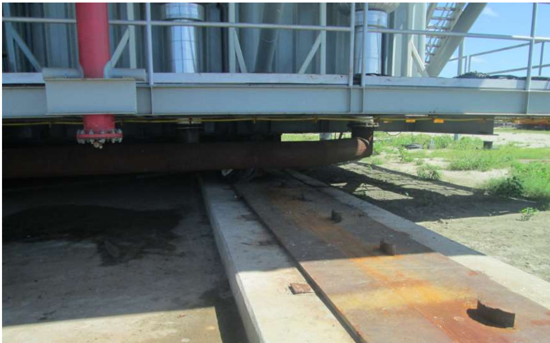
Fig.106. Área de la Corredera 1 a la que se le realizara las actividades de mantenimiento y rehabilitación.
