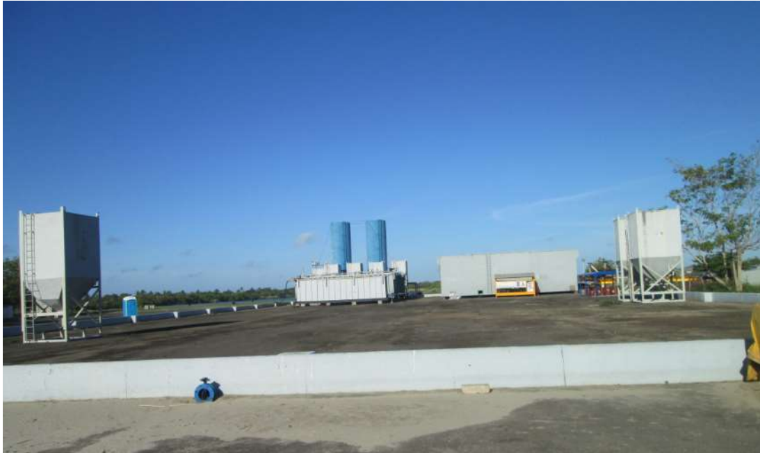
Fig.109. Plataforma de lodos a la que se le realizara las actividades de mantenimiento y rehabilitación.
