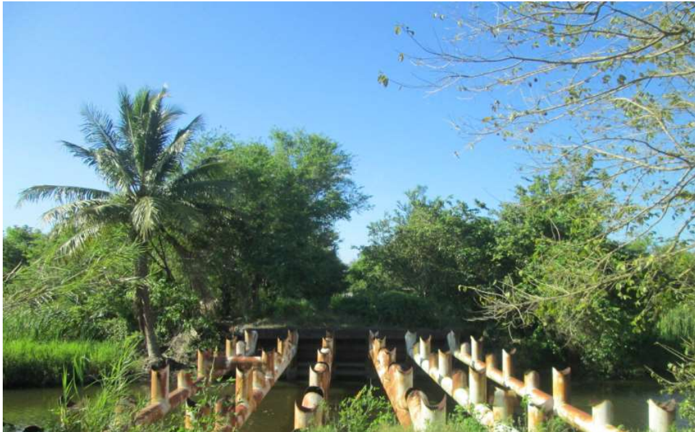
Fig.119. Puente tubular se le realizara las actividades de mantenimiento y rehabilitación.
