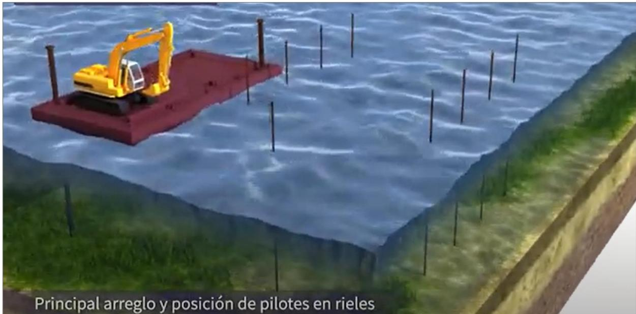
Figura 4. Arreglo temporal y posicionamiento de rieles para la correcta alineación de los tubos geotextiles que conforman un sistema de protección costera.
