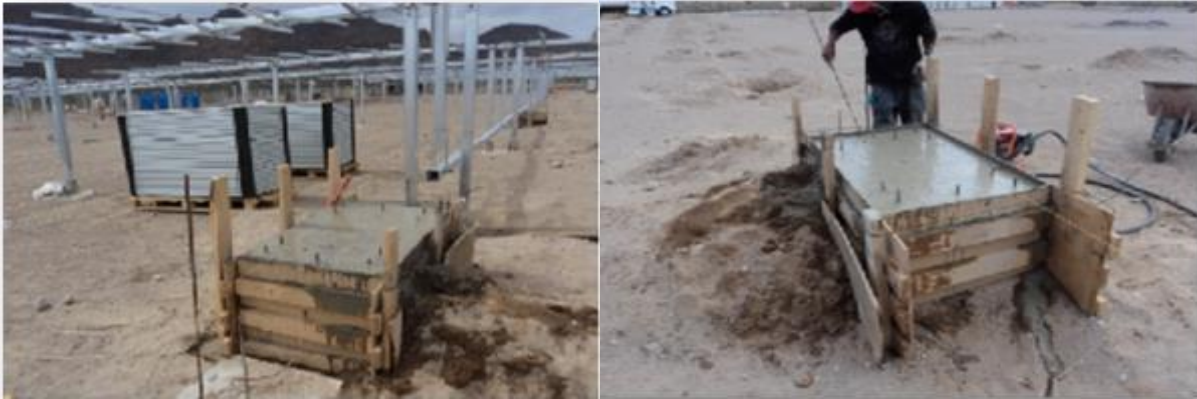
Figura II.30.- Colocación de plantillas, acero de refuerzo, cimbra y colado de cimentaciones de estructuras para centrales fotovoltaicas.
