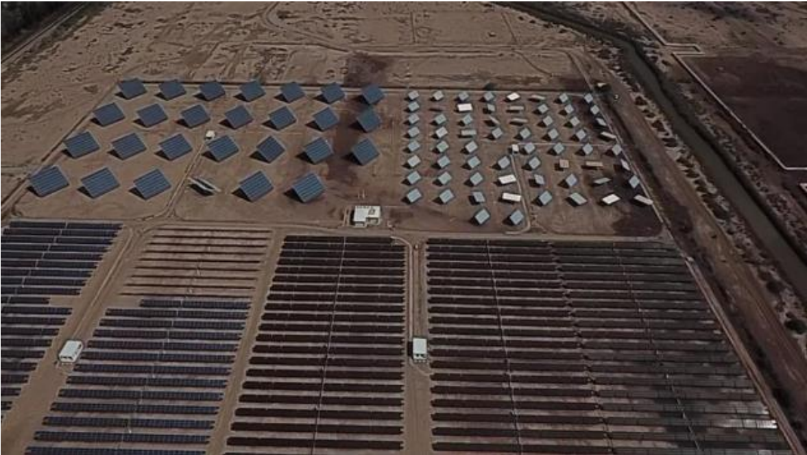
Figura II.26.- Caminos interiores en la central piloto de 5 MW en el Cerro Prieto.
