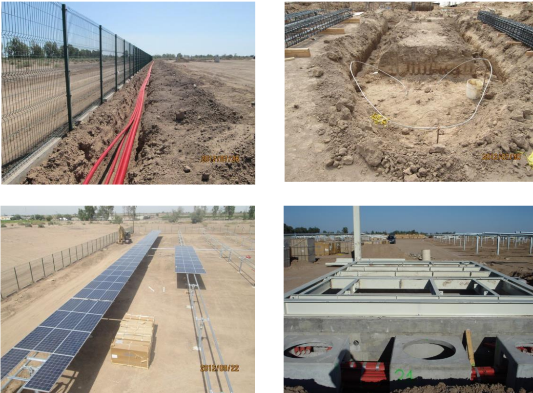
Figura II.33.- Montaje de módulos fotovoltaicos, instalación de cableado eléctrico y de equipos de medición.
