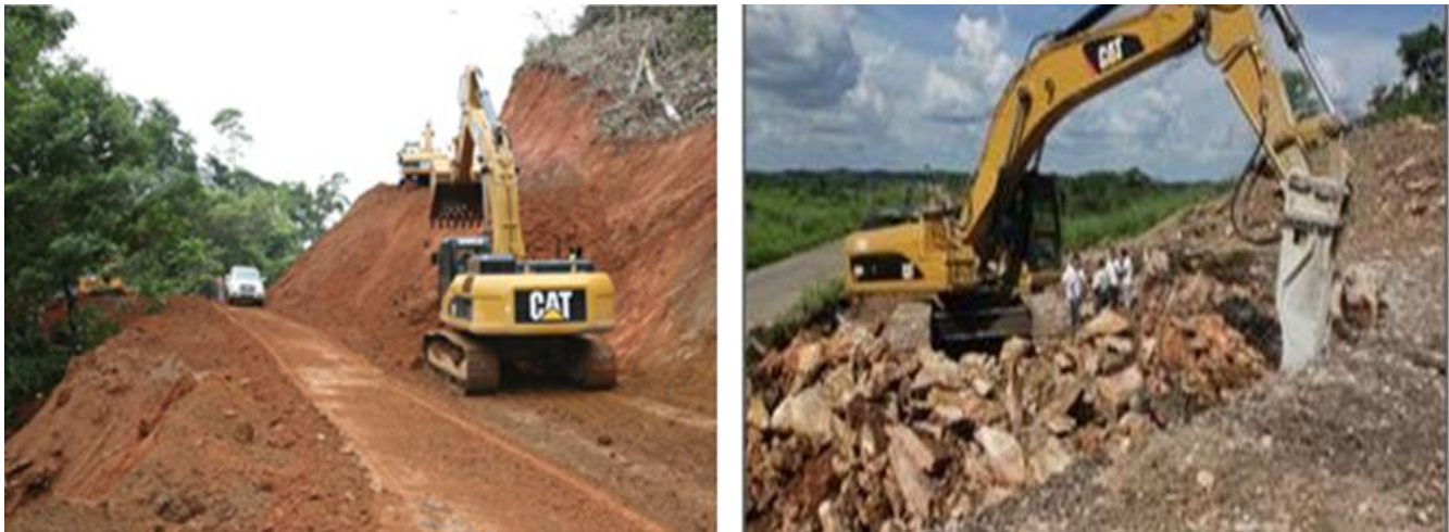
Figura II.13 Ejemplo de las actividades de excavación en cortes
