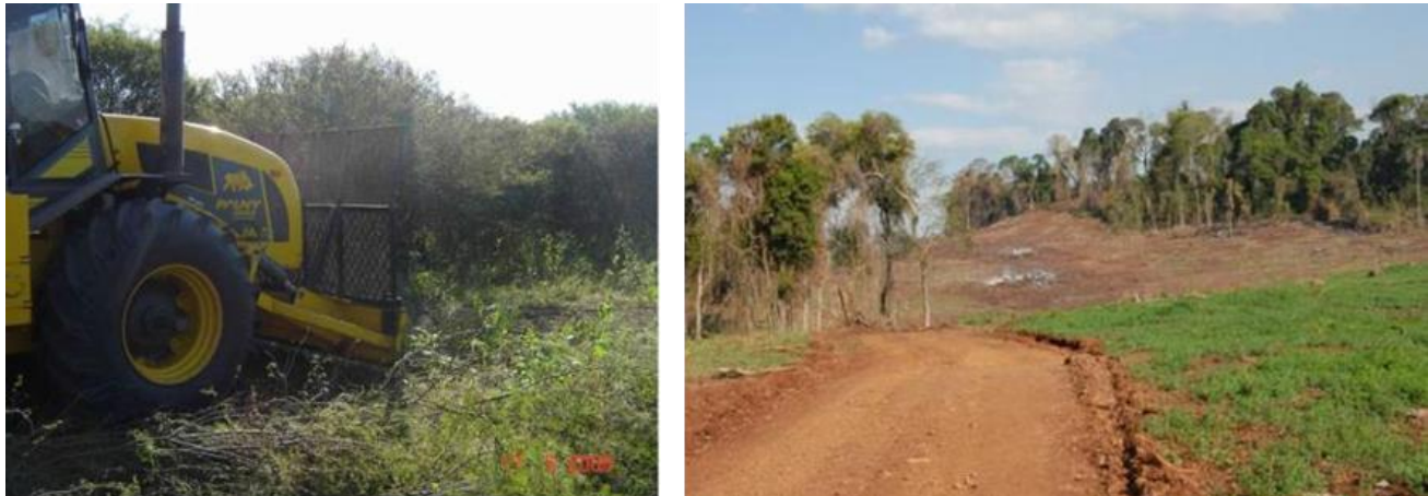
Figura II.11 Ejemplo de desmonte en obras similares.
