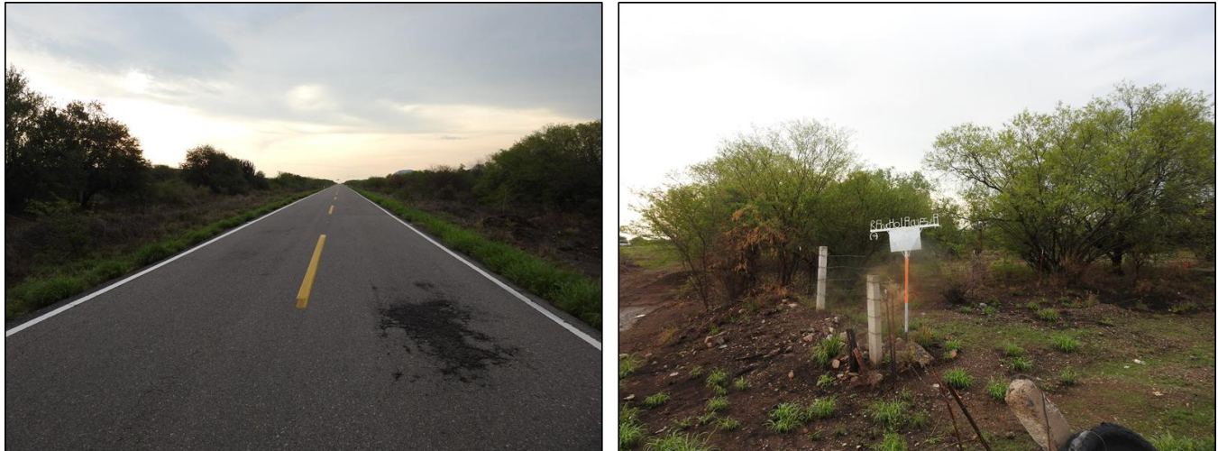
Figura II.12 Vista de la carretera federal Hermosillo – Yécora km 94+000 y entrada a la localidad de La Cuesta.
