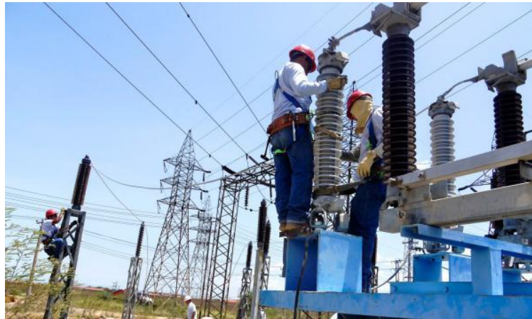
Foto II-13 Colocación de aisladores tipo.
