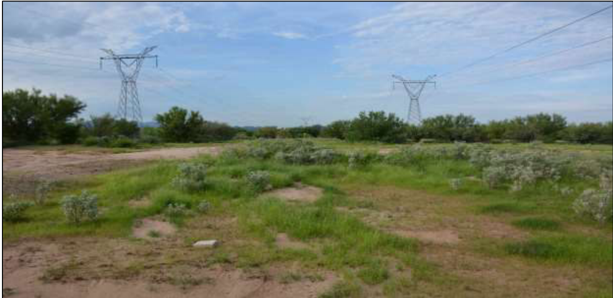
Foto V-2 Estructuras de soporte de la LTE aleadaña.
