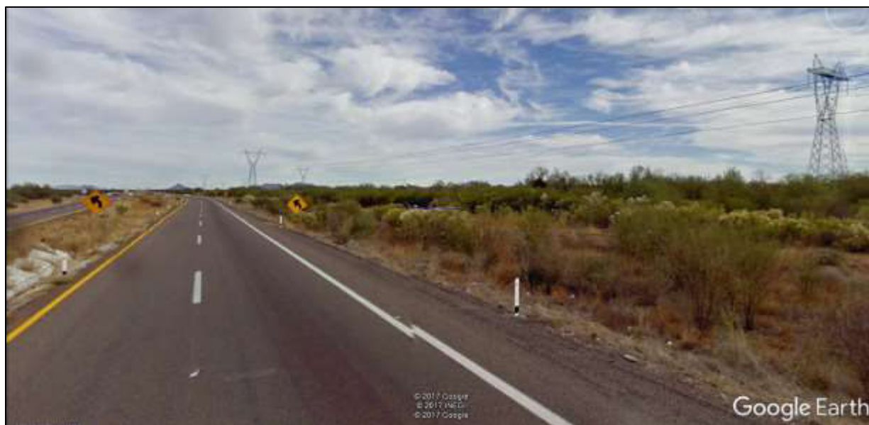
Foto V-1 Vista panorámica de la LTE Hermosillo V-Guaymas.
