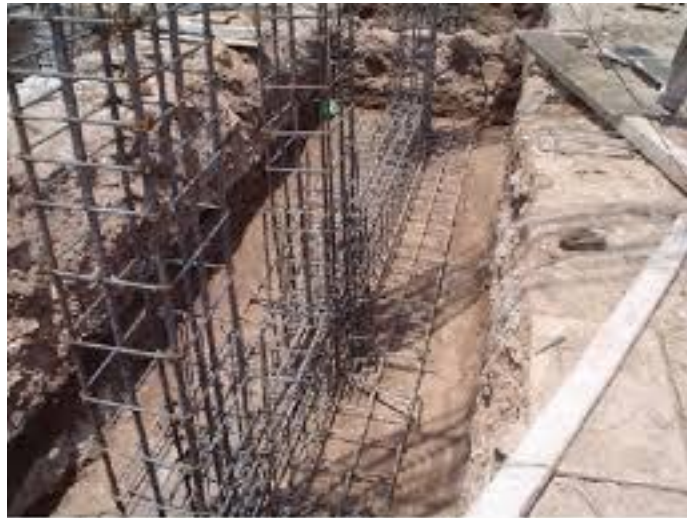
Foto II-11 Ejemplo de cimbra de soportes para estructuras.
