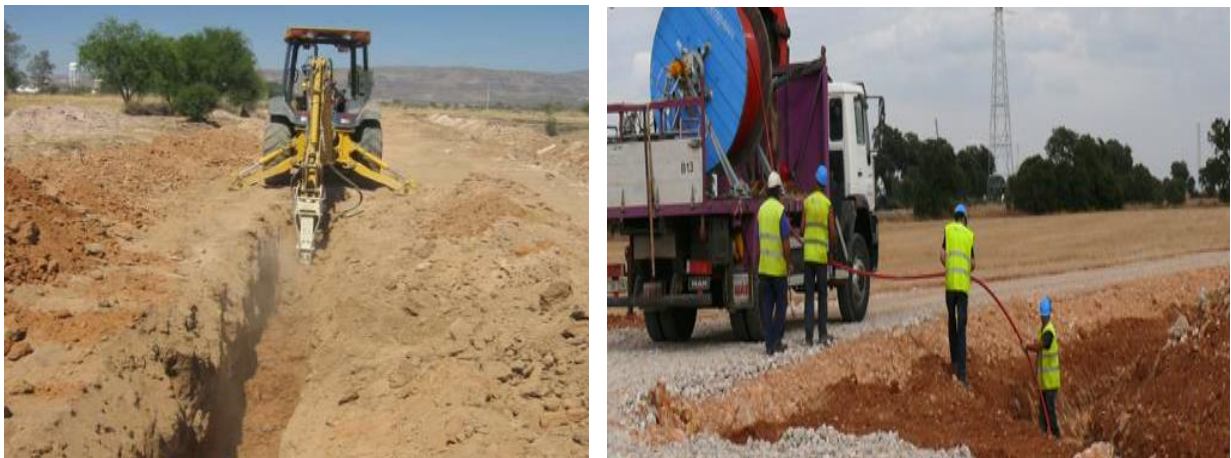
Foto II-10 Representación de la excavación de zanjas y tendido del cableado eléctrico.
