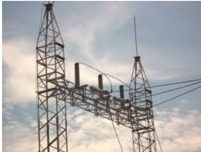
Foto II-12 Montaje de traveses metálicas tipo.
