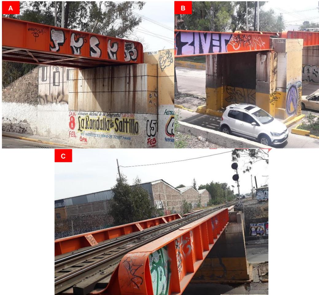
Figura 7. Estribos (A), pilas (B) y armadura metálica (C)
