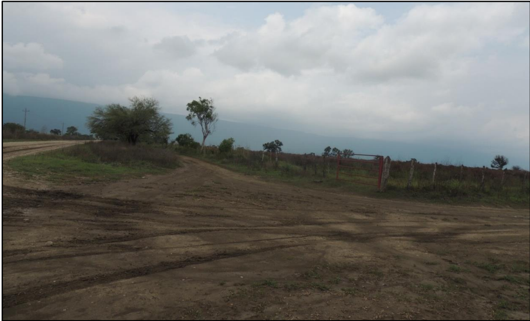
Figura IV.16 Vista de los procesos erosivos hídricos presentes es el SAR, especialmente en los caminos de acceso.
