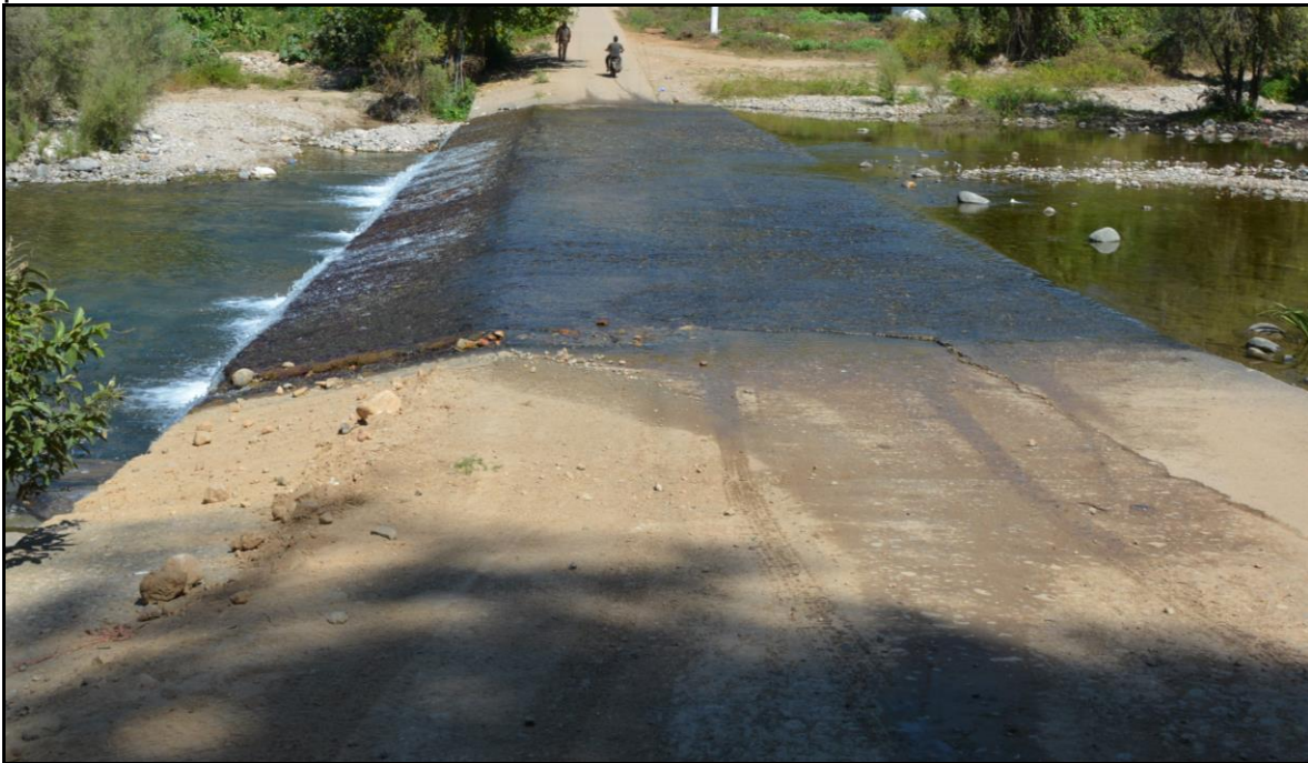
Figura No. 55 Acercamiento a la estructura del puente-vado existente.
