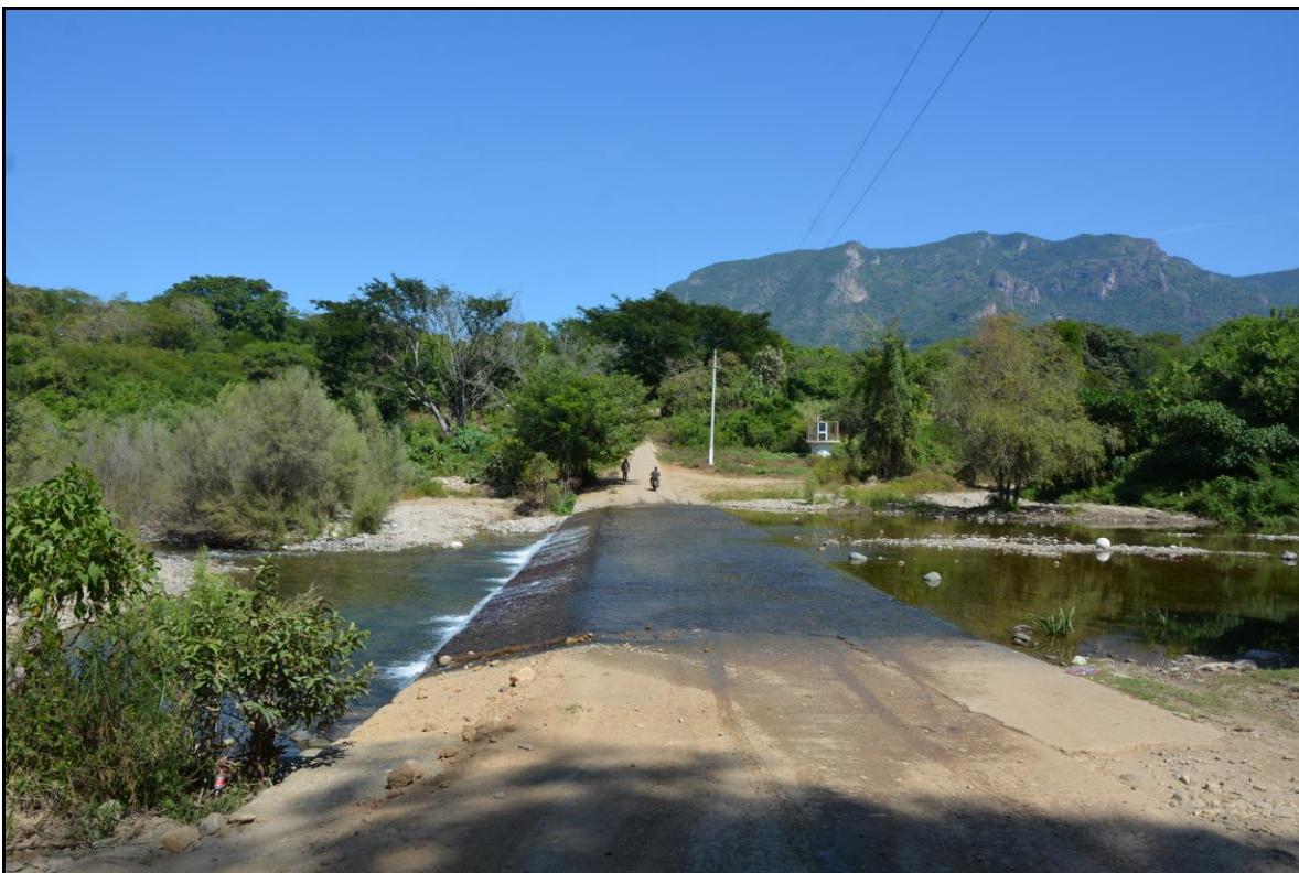
Figura No. 1 Puente Vado actual el cual se pretende sustituir por el puente vehicular.
