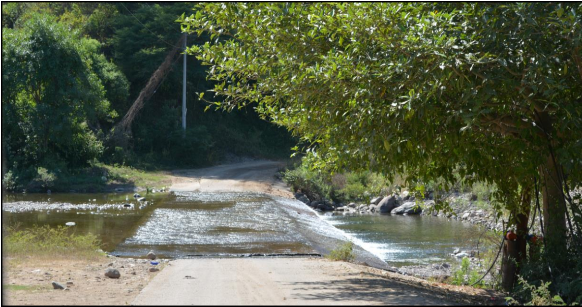
Figura No. 16. Área del sitio del puente en la carretera San Ignacio-Tayoltita tramo San Juan-Vado Hondo. Fotografía tomada en dirección a la población San Juan.
