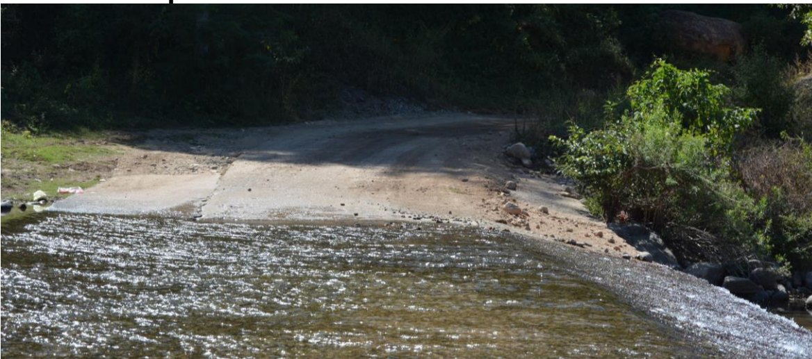
Figura No.15 Acercamiento. Vista del acceso Sur (margen izquierda) del arroyo Los Frailes.
