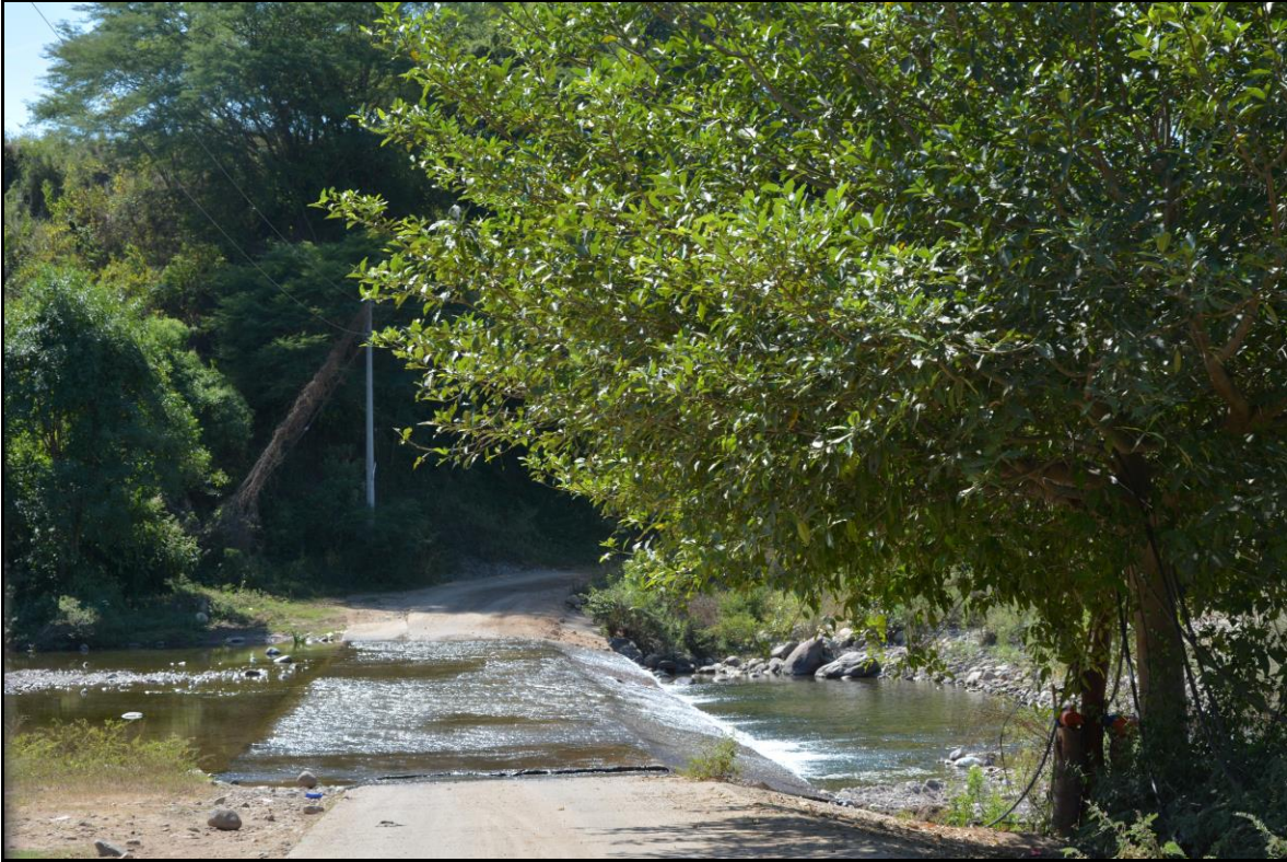
Acercamiento a la zona del vado existente para cruzar el arroyo Los Frailes.
