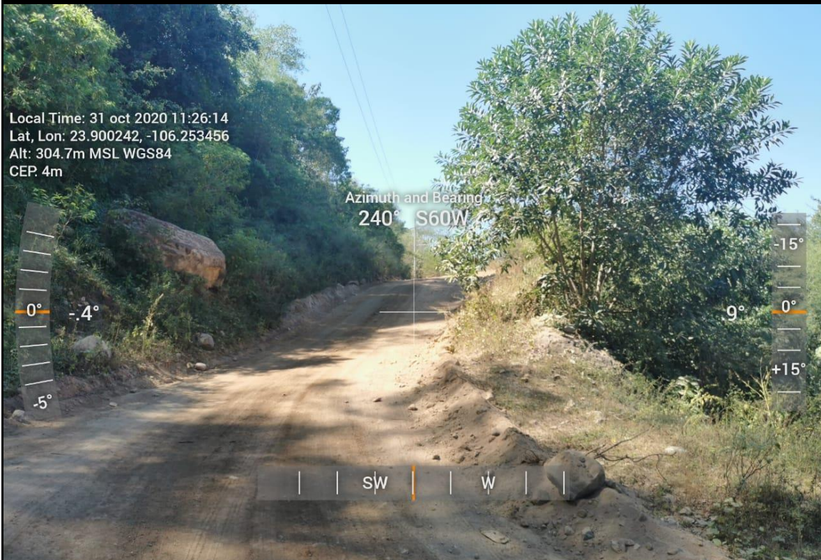
Arriba: Vista Sur-Sureste del sitio del proyecto. Cauce del arroyo aguas abajo. Abajo: Vista Oeste-Suroeste. Camino de acceso al puente.
