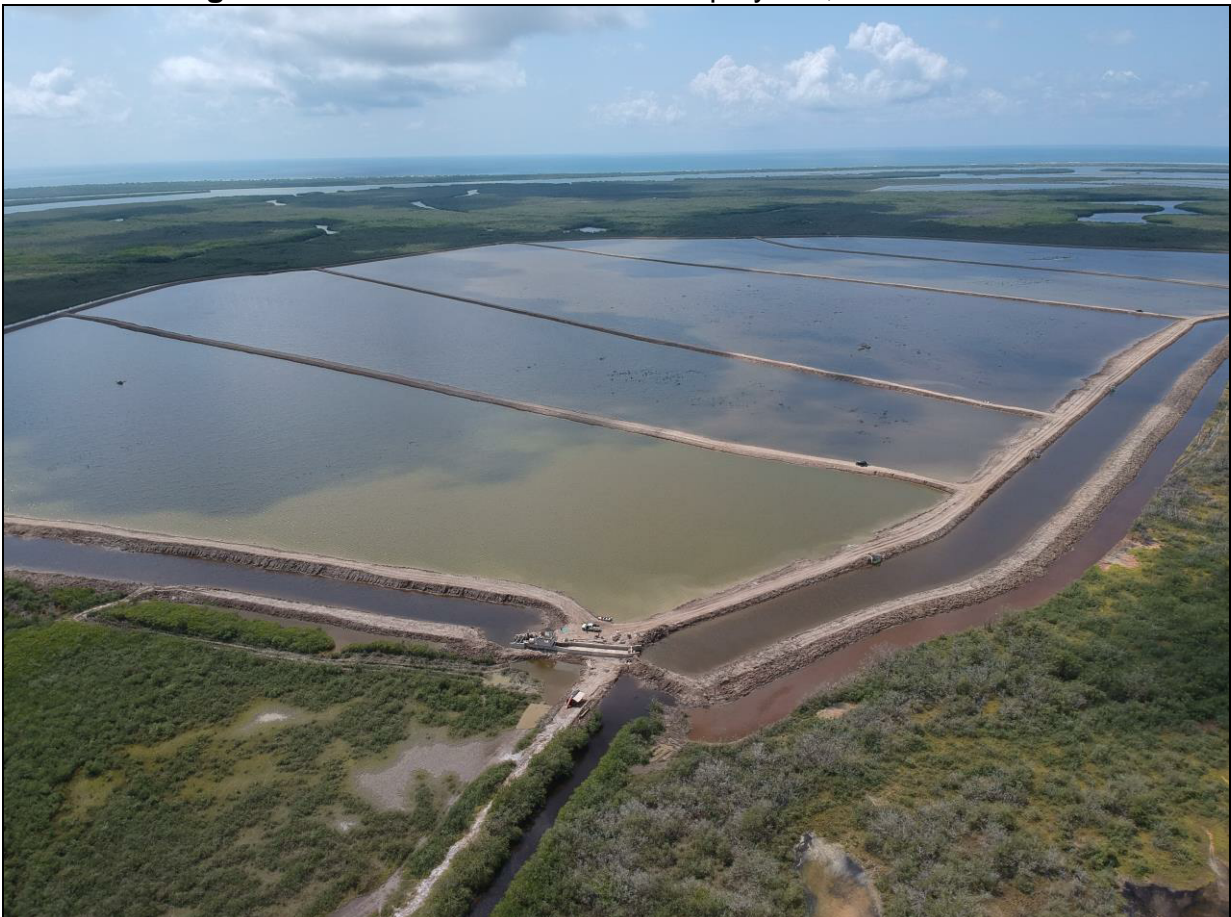
Fotografía VI.1.- Vista Panorámica del proyecto, de Este a Oeste.
