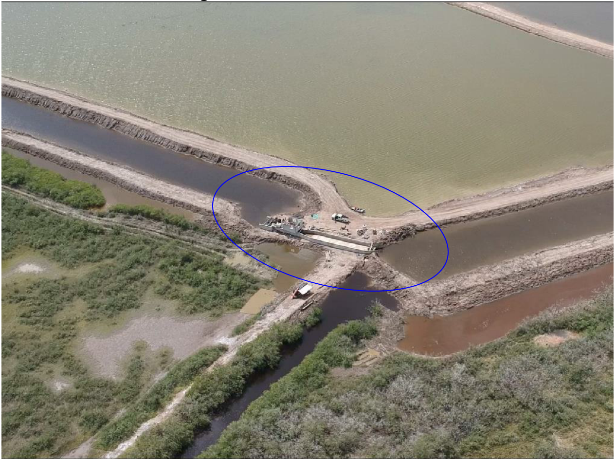
Fotografía II.3- Cárcamo de bombeo.
