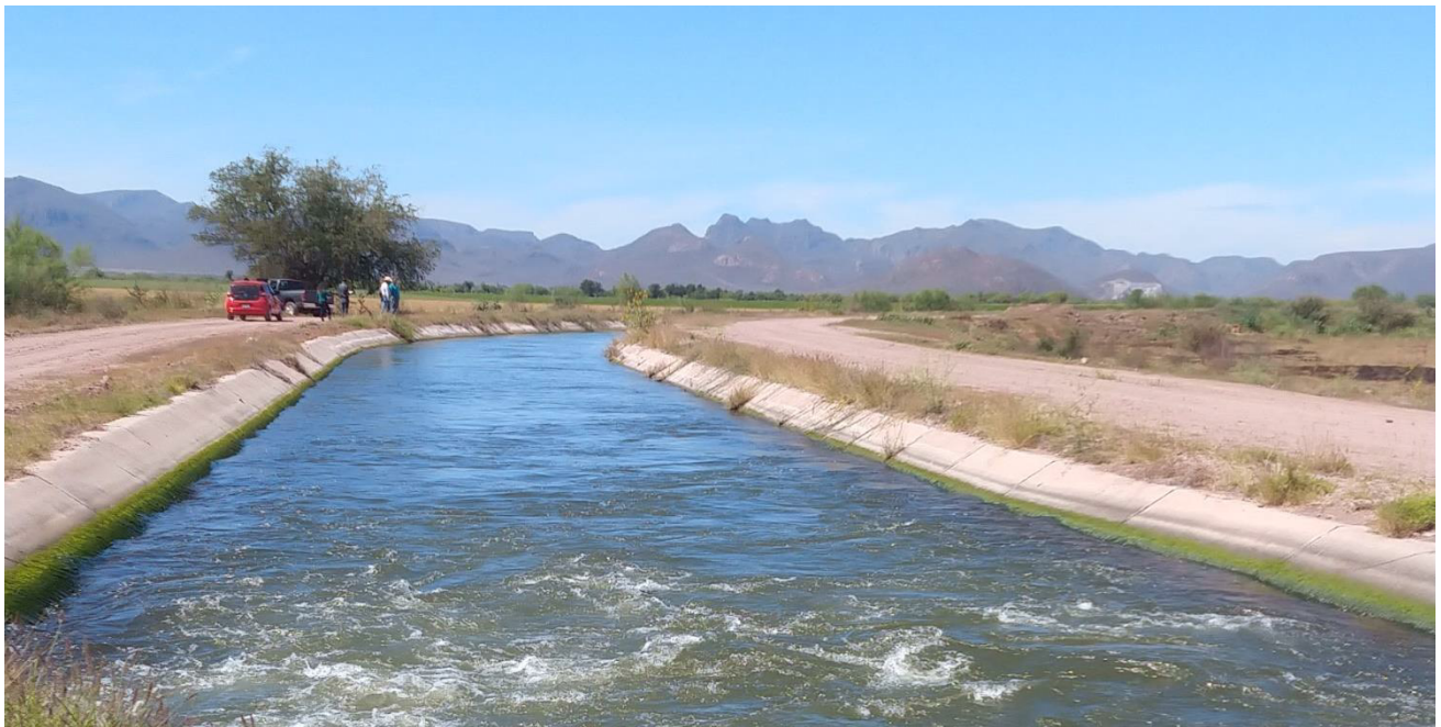
Fotografía 12 Vista del Canal Principal Sur.
