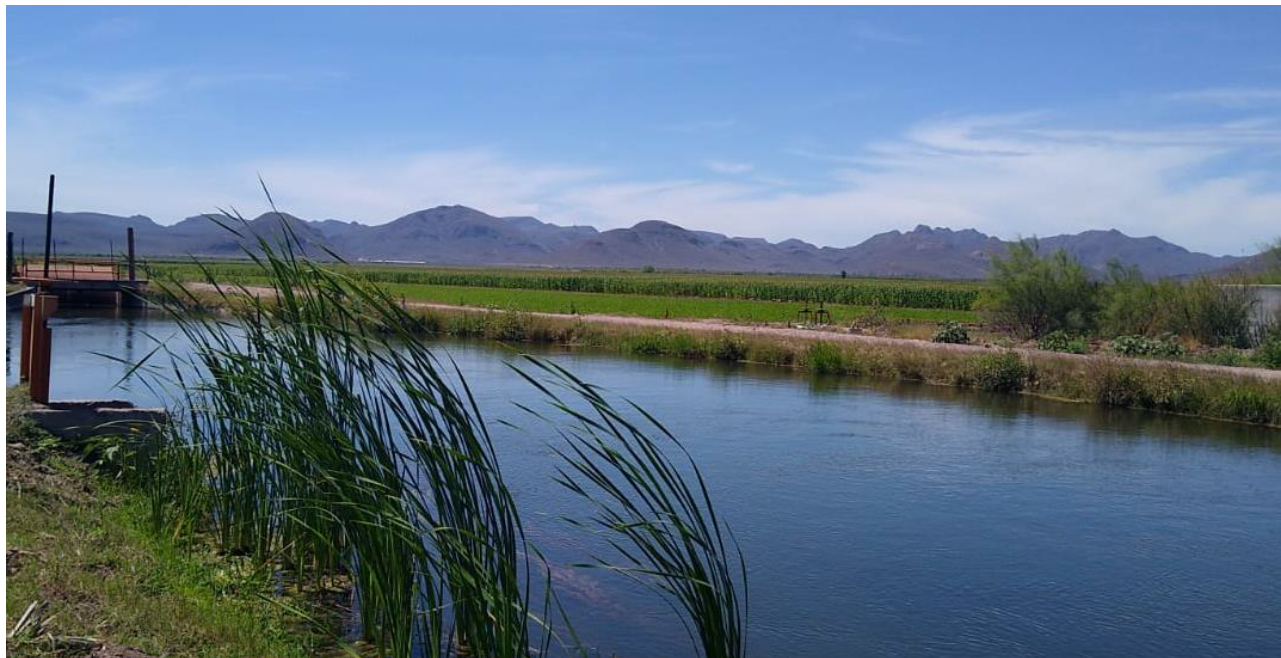
Fotografía 8. Vista de uno de los canales de la amada
