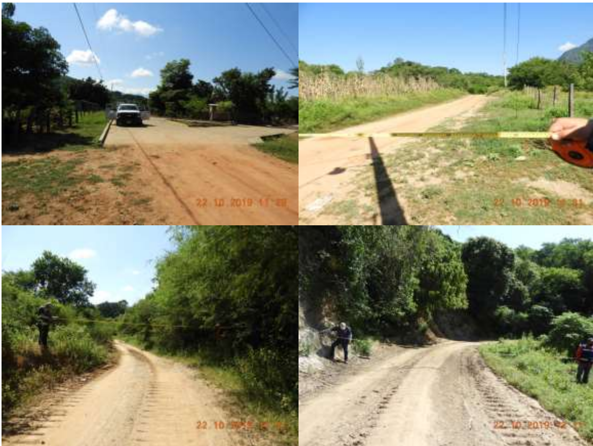
Figura VII.1 Condiciones actuales del sitio del proyecto.
