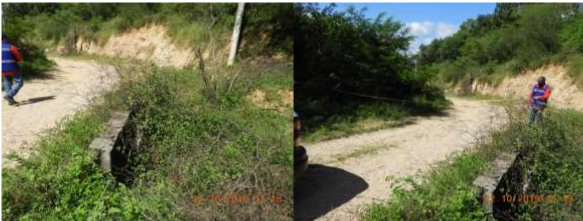
Figura IV.17 Ejemplo de las obras de drenaje presentes sobre el trazo del proyecto.
