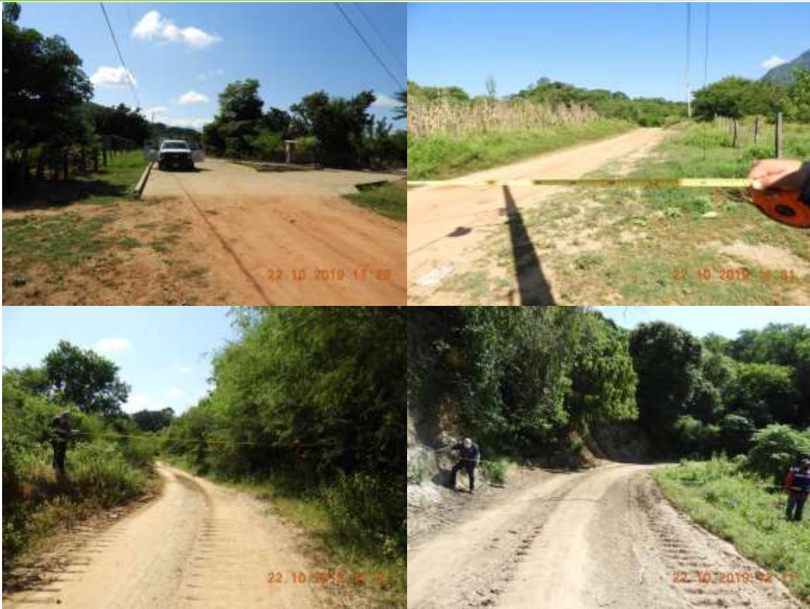
Figura VIII.2 Condiciones actuales del sitio del proyecto.
