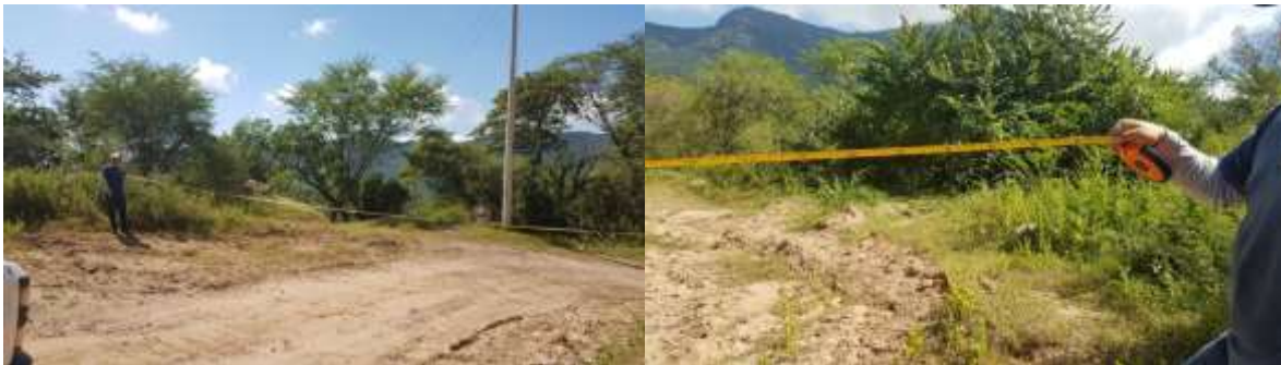
Figura II.40 Condiciones del camino actual.
