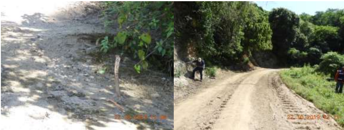
Figura II.32 Condiciones del camino actual.
