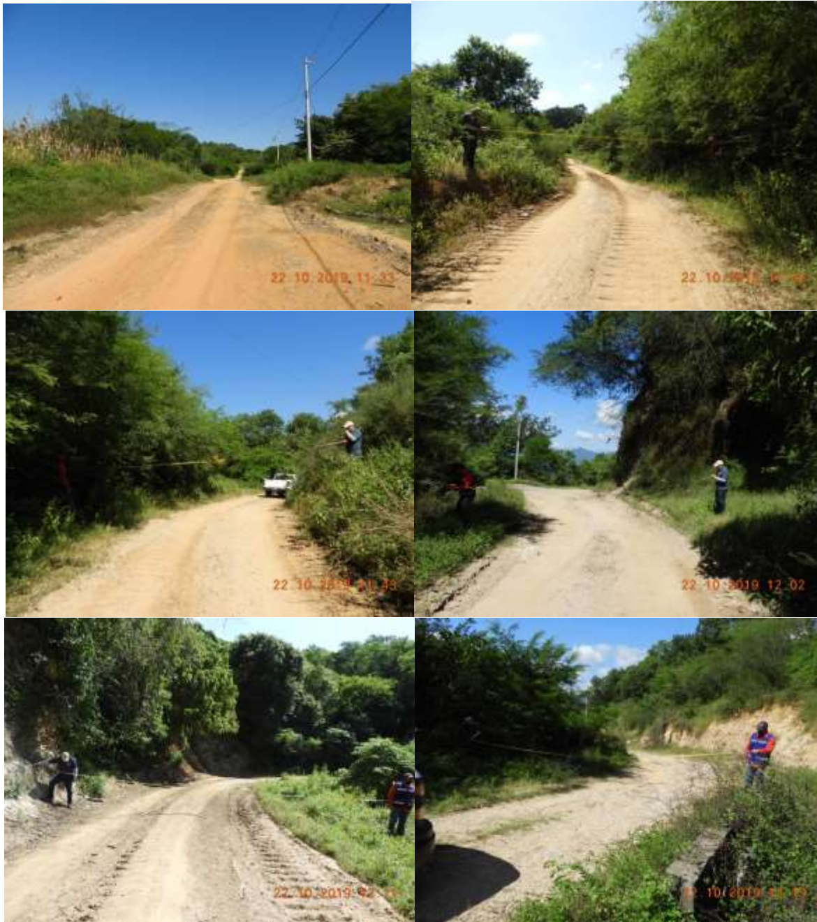
Figura II.12 Características del trazo geométrico. En las imágenes se pueden observar las condiciones del camino actual y del uso de suelo vigente en el área del proyecto.
