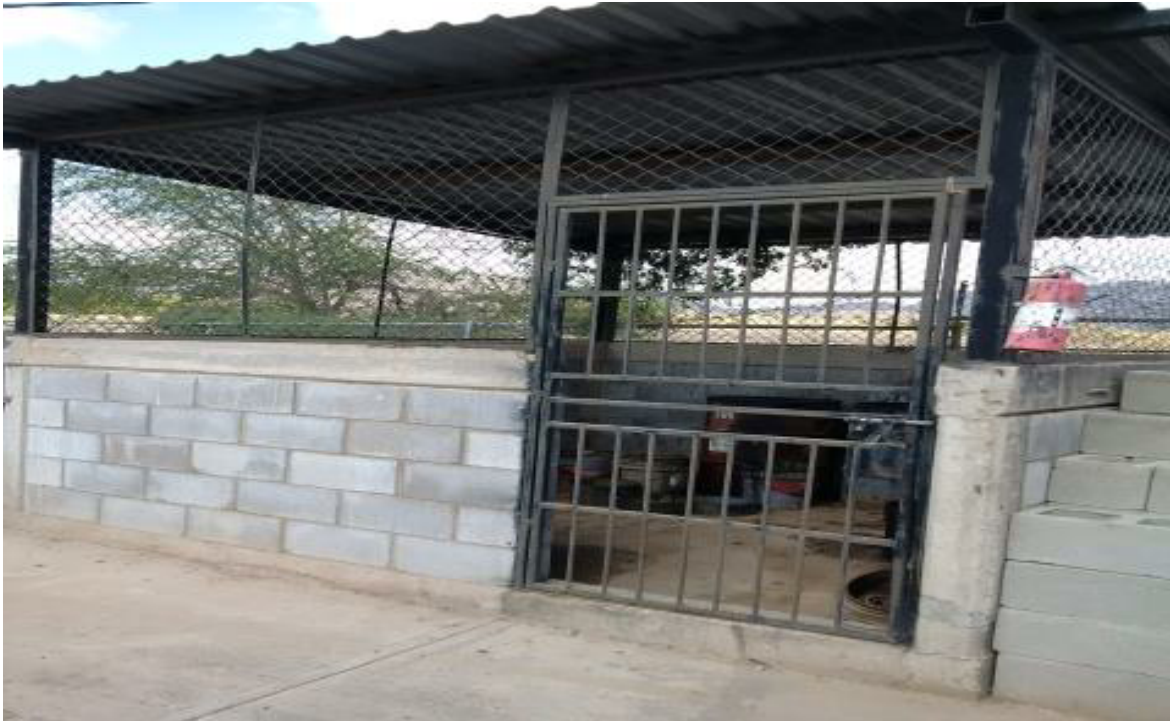
Imagen 22. Vista de almacén temporal de residuos peligrosos.
