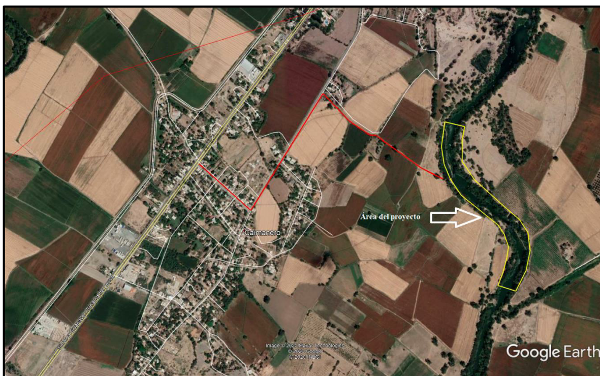
Imagen No. 31.- Acceso al área del proyecto
