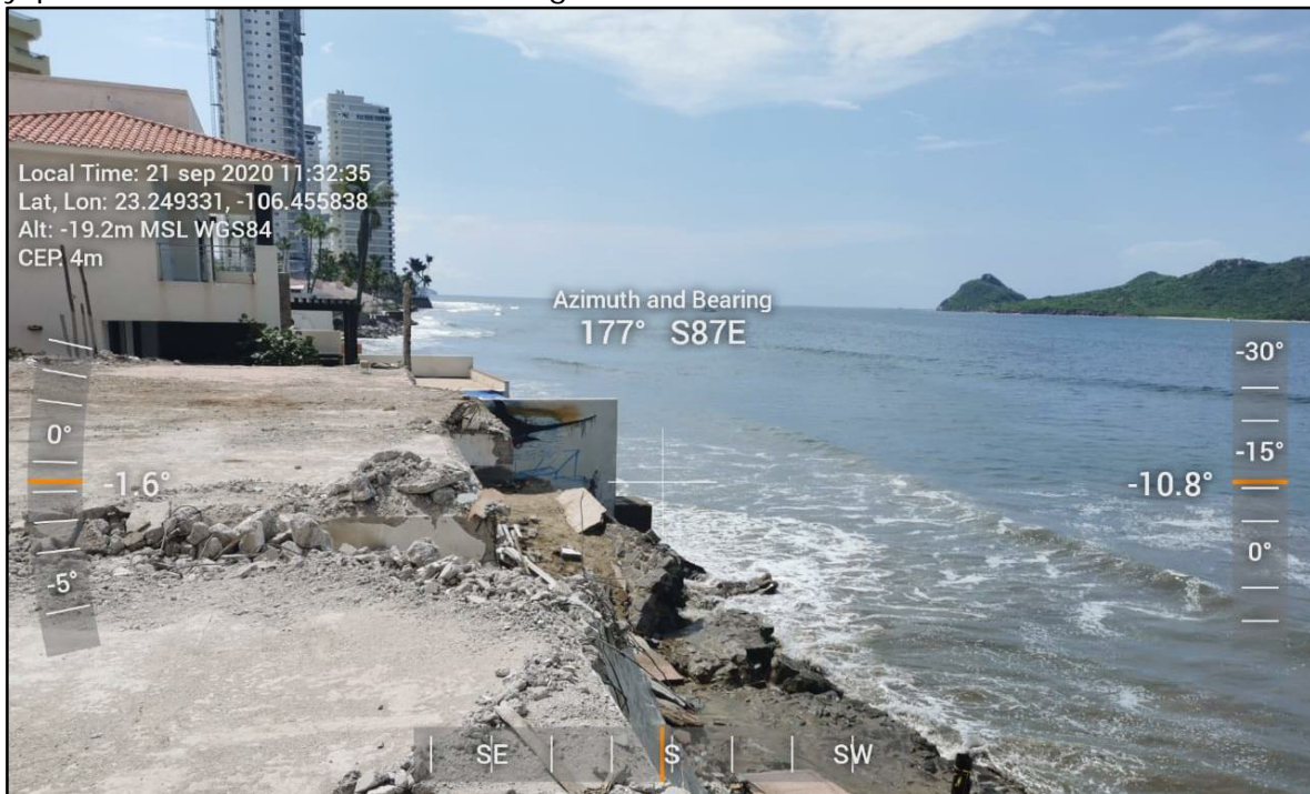
Figura No. 41 Cdi ndand a suroeste del predio. Sitio donde se construirá el muro de contención marginal.
